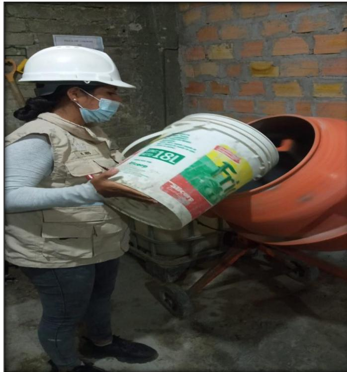
**Anexo 41:** Panel fotográfico N° 12 – Adición de las tiras de caucho reciclado para la elaboración del concreto  $f'c=210$  kg/cm<sup>2</sup>
