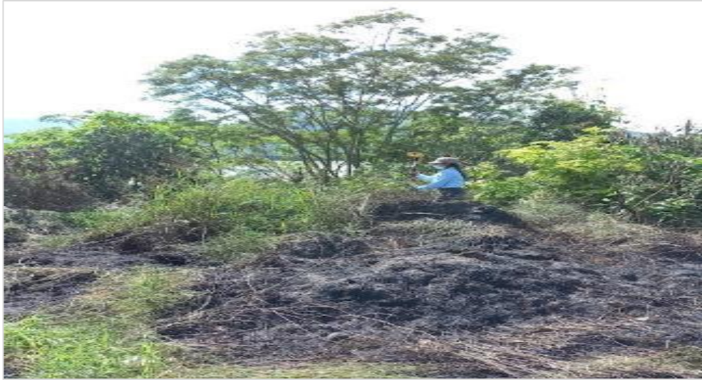
Figura 7: Levantamiento topográfico en la zona inaccesible del talud inferior
