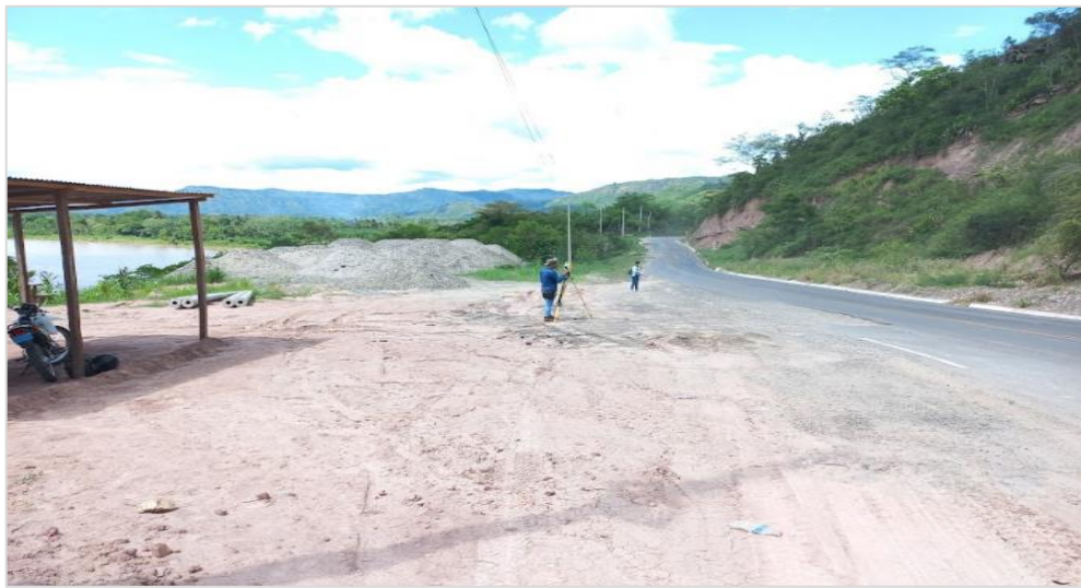
Figura 10: Levantamiento topográfico de la parte final del talud inferior
