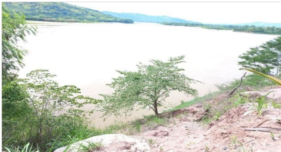
Figura 4: Identificando las características del suelo en el talud inferior
