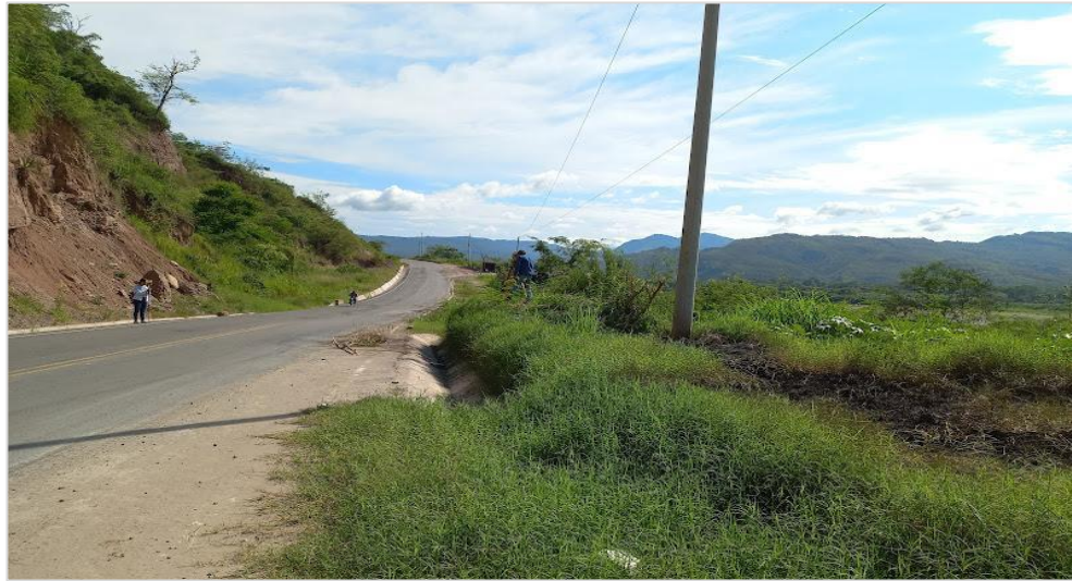
Figura 5: Determinando puntos de control para el levantamiento topográfico
