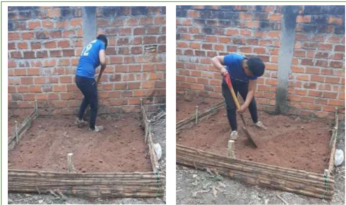
Figura 10: Relleno de las parcelas.
