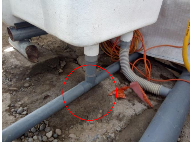
Figura 5: Tubería de desagüe de agua viciada Fuente: Empresa Inkas Trout E.I.R.L
