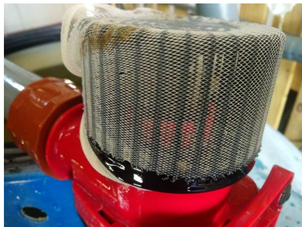
Figura 19: Malla protectora de bomba Fuente: Empresa Inkas Trout E.I.R.L
