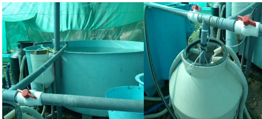
Figura 11: Instalaciones de agua y desagüe en tanques circulares
