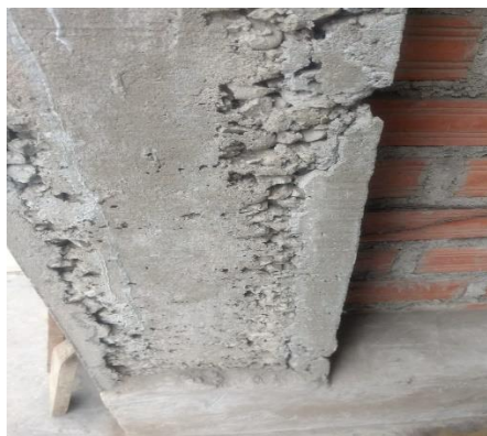
Figura 17. cangrejeras en columna con exposición, Fuente: Propia
