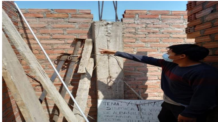
Figura 16. Muros con ladrillo pandereta en segundo nivel
