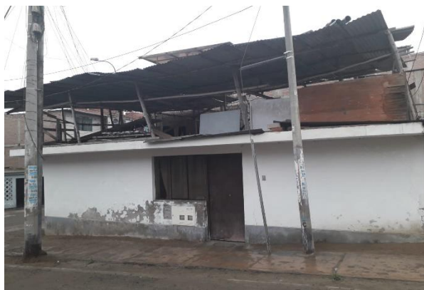
Figura 12. Vivienda localizada en pendiente
