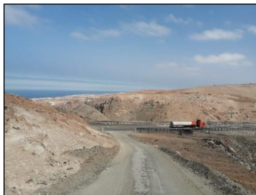
Figura 13.- Vía de ingreso a botadero. FUENTE: Elaboración propia
