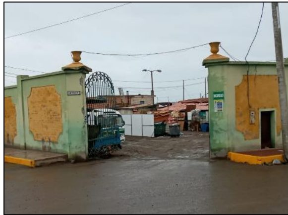
Figura 16.- Fachada de Depósito Municipal o almacenamiento temporal.
