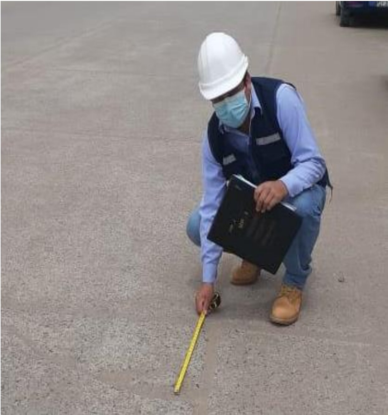
Toma 04: Vista de pulimiento de agregados de una densidad alta.
