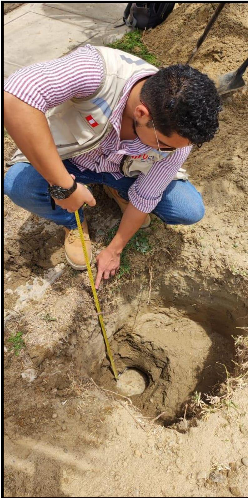
**Figura 102.** Medición de la napa freática en la calicata N° 03.
