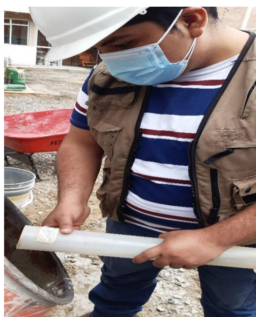
Fotografía N° 20. Incremento de agua por adición de CCA en elaboración de concreto adicionado.
