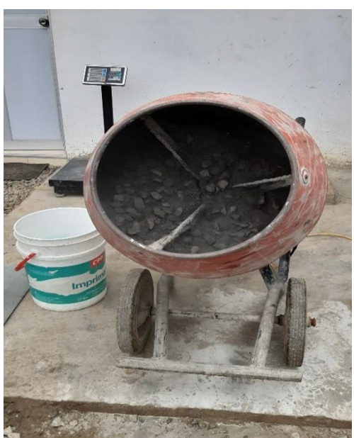
Fotografía N° 19. Mezclado concreto con CCA como sustituto parcial de peso de cemento en %, 10 y 15%.
