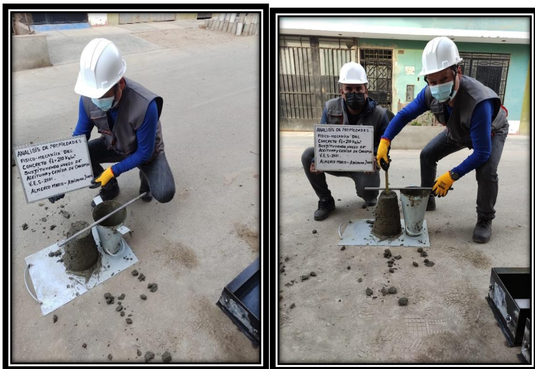
Figura 35. Determinación del Slump
