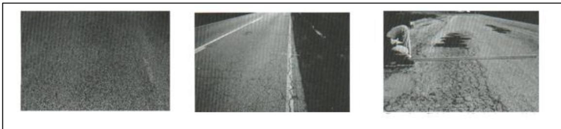
**Exudación**, parte bituminosa, brillante, cristalina, reflectora y hasta pegajosa, el cual se encuentra de manera superficial en la capa de rodadura del pavimento, el cual se ocasiona a causa de una gran presencia del asfalto en la mezcla. (Vasquez,2002, p.12).
