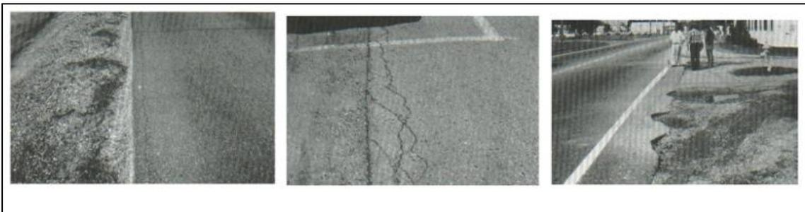
Es la discrepancia existente entre el borde de la superficie del pavimento con la de la berma, así como también puede ser generada por una incorrecta colocación de las carpetas en la calzada (Vasquez,2002, p.27).
