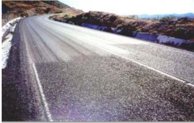
**FIGURA 8.** Falla por meteorización o desprendimiento del agregado
