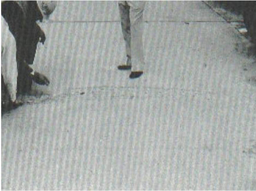
Figura 12: Grieta de durabilidad de severidad media
