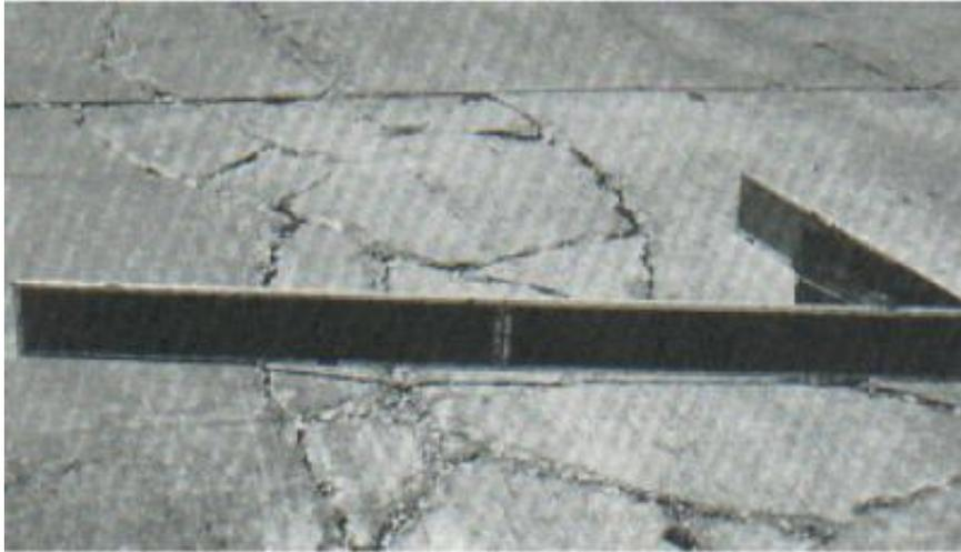
Figura 39: Punzonamiento de alta severidad
