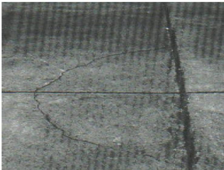
Figura 7: Grieta de esquina de baja severidad
