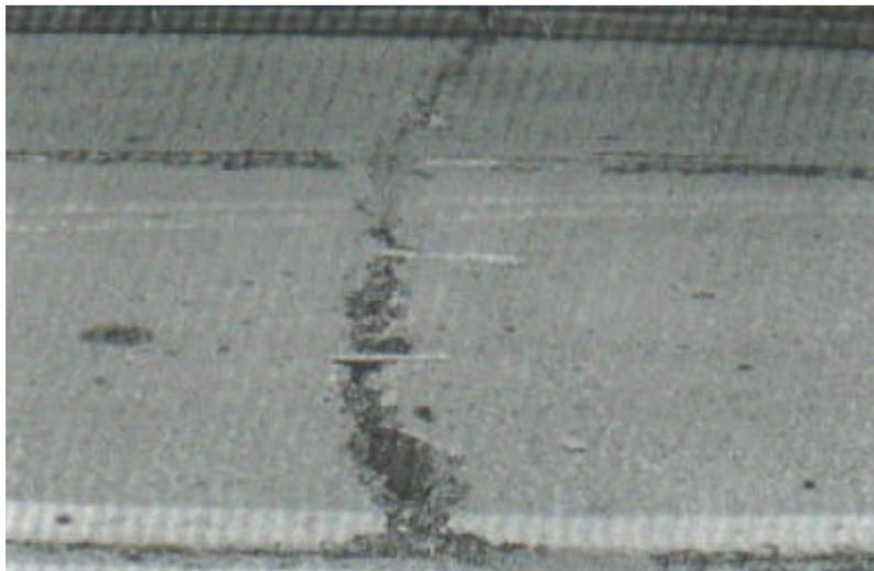
Figura 26: Grietas lineales de alta severidad en losa de concreto simple
