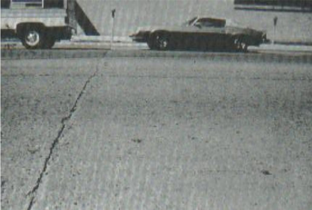
Figura 50: Descascamiento de junta de baja severidad
