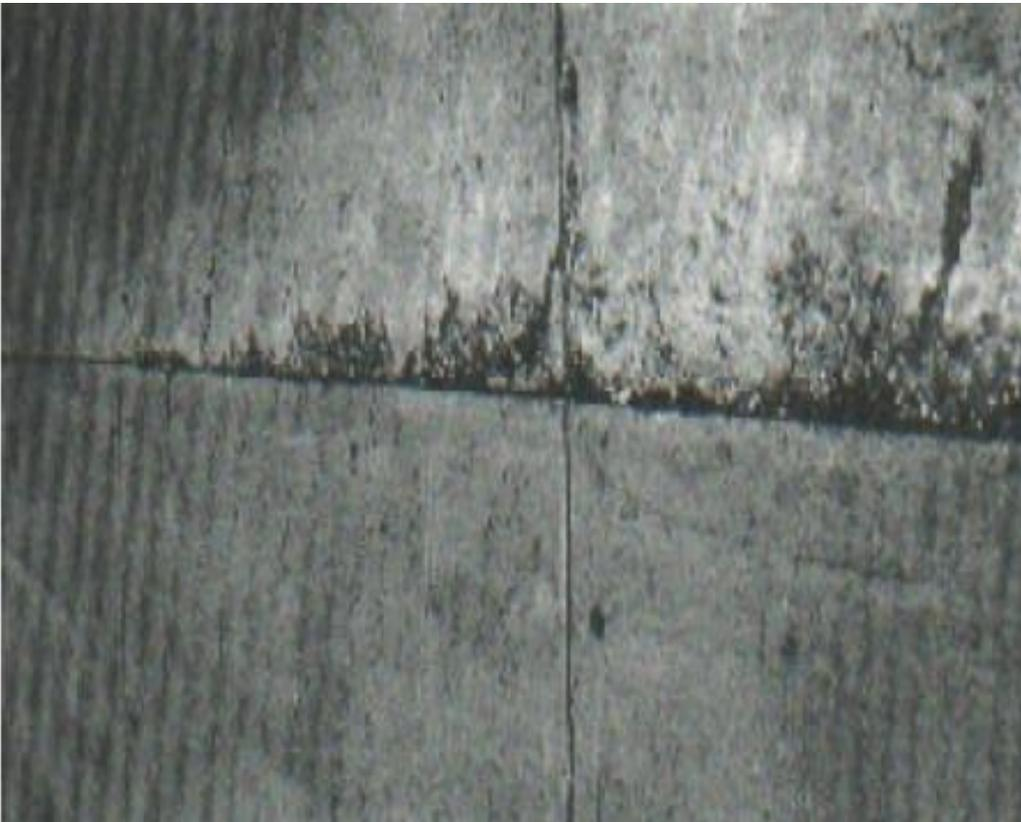
Figura 51: Descascaramiento de junta de severidad media
