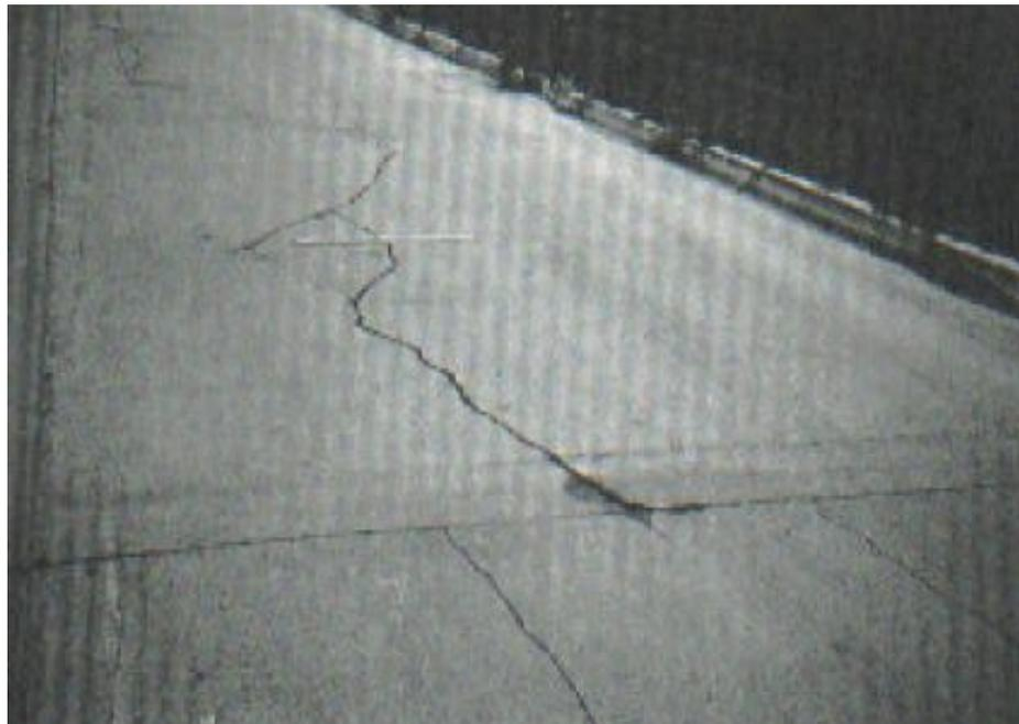
Figura 9: Losa dividida de severidad media.
