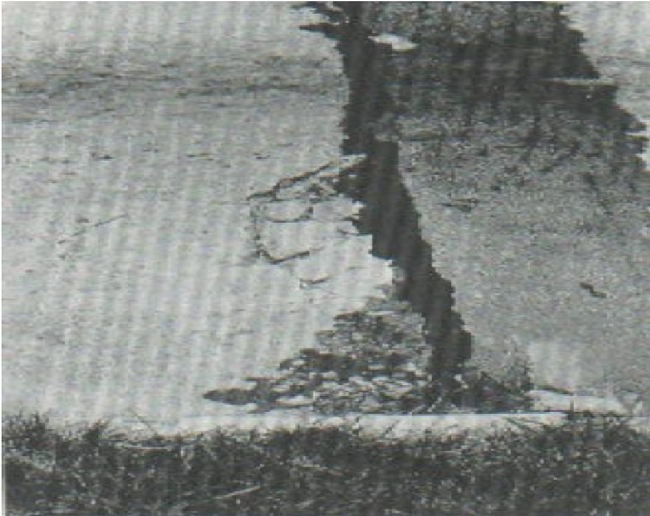
Figura 4: Blowup / Bucking de baja severidad
