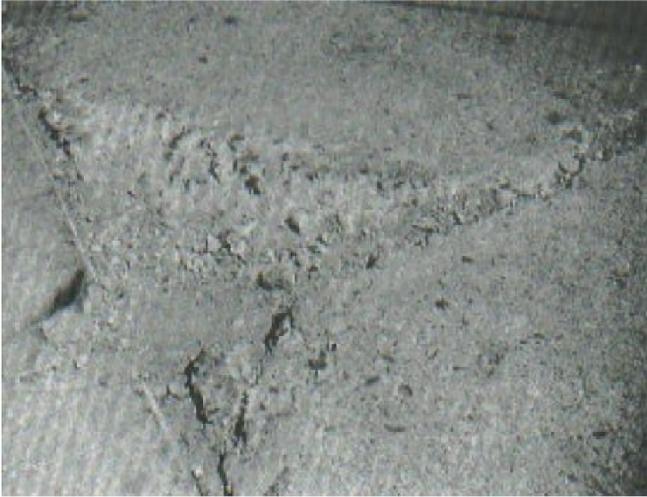
Figura 49: Descascaramiento de esquina de alta severidad
