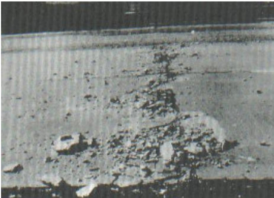
Figura 5: Blowup / Bucking de baja severidad
