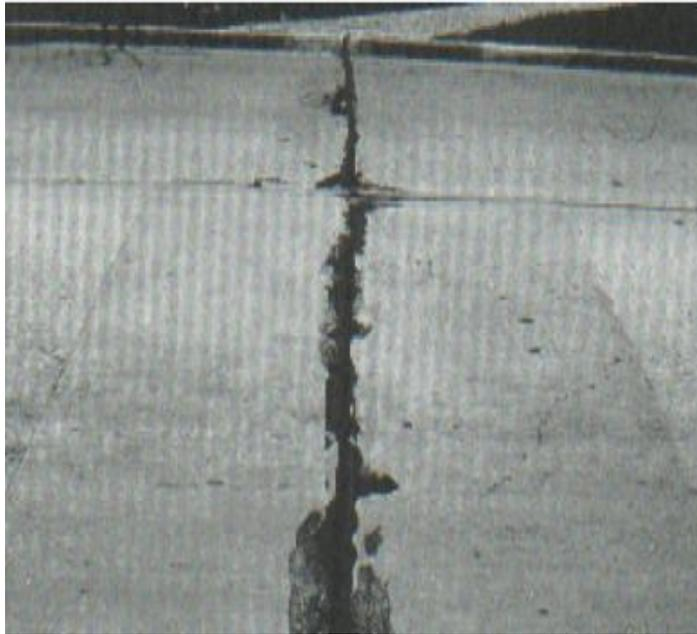
Figura 18: Daño del sello de junta de baja severidad
