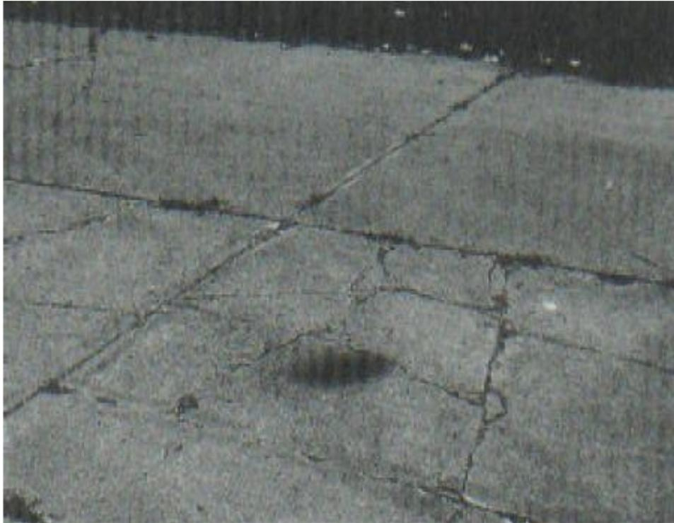
Figura 10: Losa dividida de alta severidad
