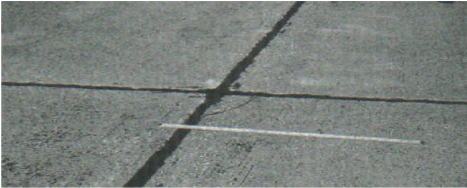
Figura 47: Descascaramiento de esquina de baja severidad
