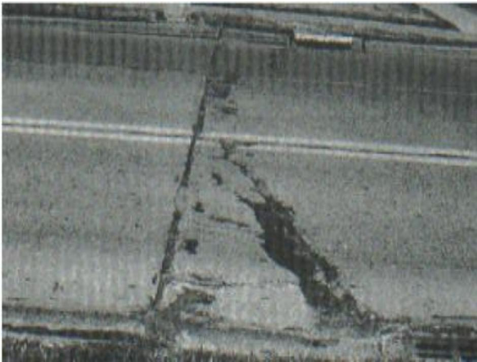
Figura 38: Punzonamiento de severidad media
