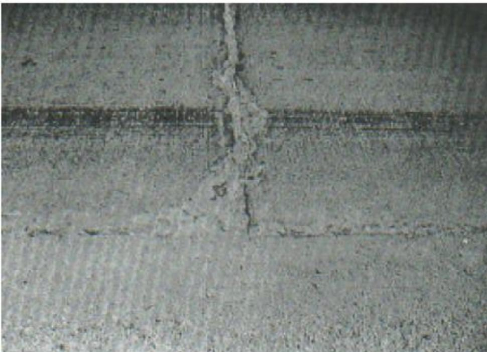
Figura 48: Descascaramiento de esquina de severidad media
