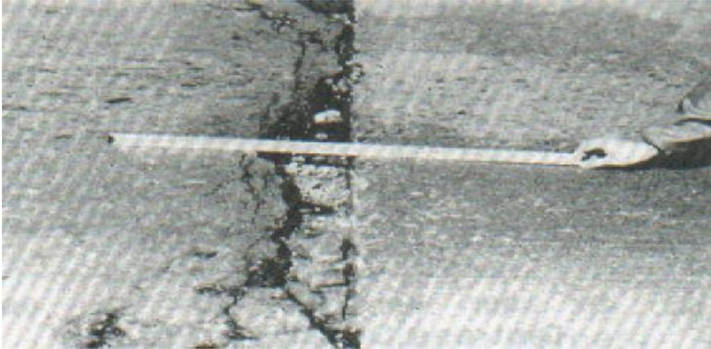
Figura 52: Descascaramiento de junta de alta severidad
