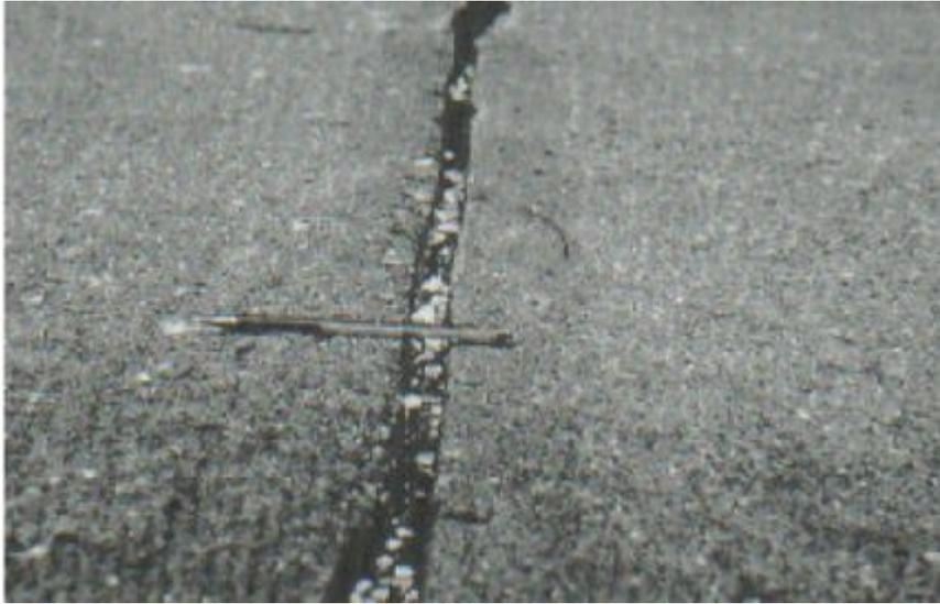
Figura 20: Daño del sello de junta de alta severidad
