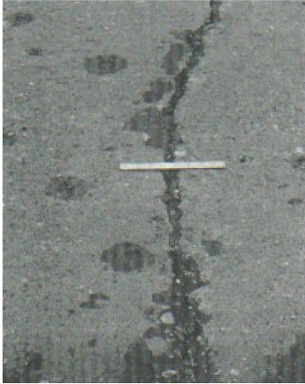
Figura 25: Grietas lineales de severidad media en losa de concreto reforzado
