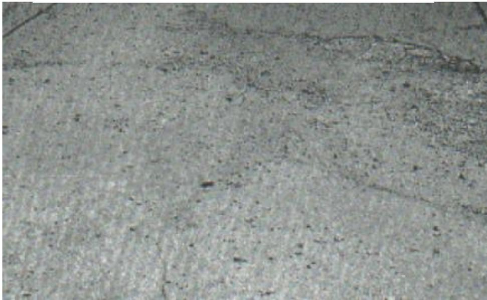
Figura 13: Grieta de durabilidad de alta severidad
