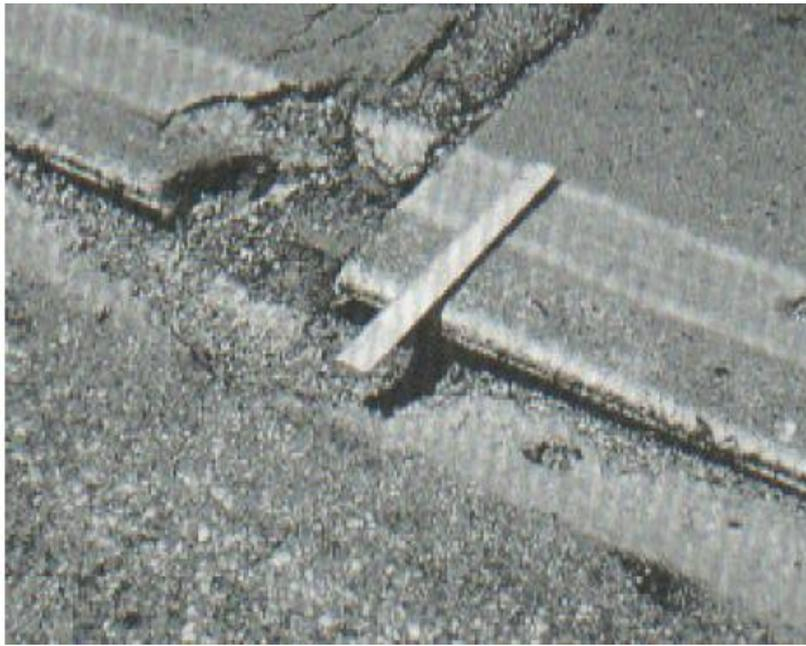
Figura 21: Desnivel carril/berma de baja severidad
