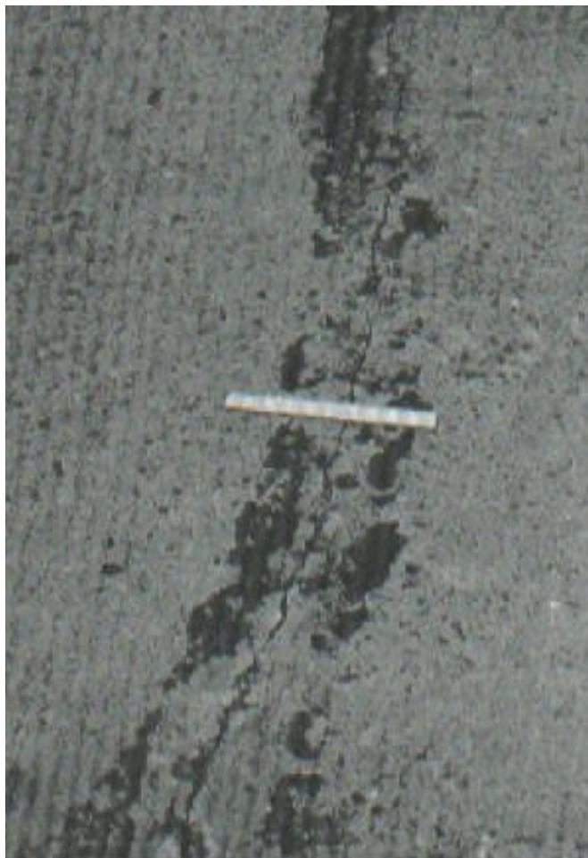
Figura 24: Grietas lineales de baja severidad en losa de concreto simple
