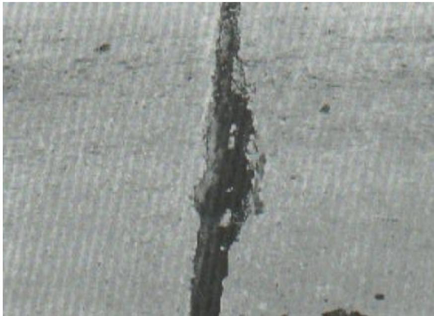
Figura 19: Daño del sello de junta de severidad media
