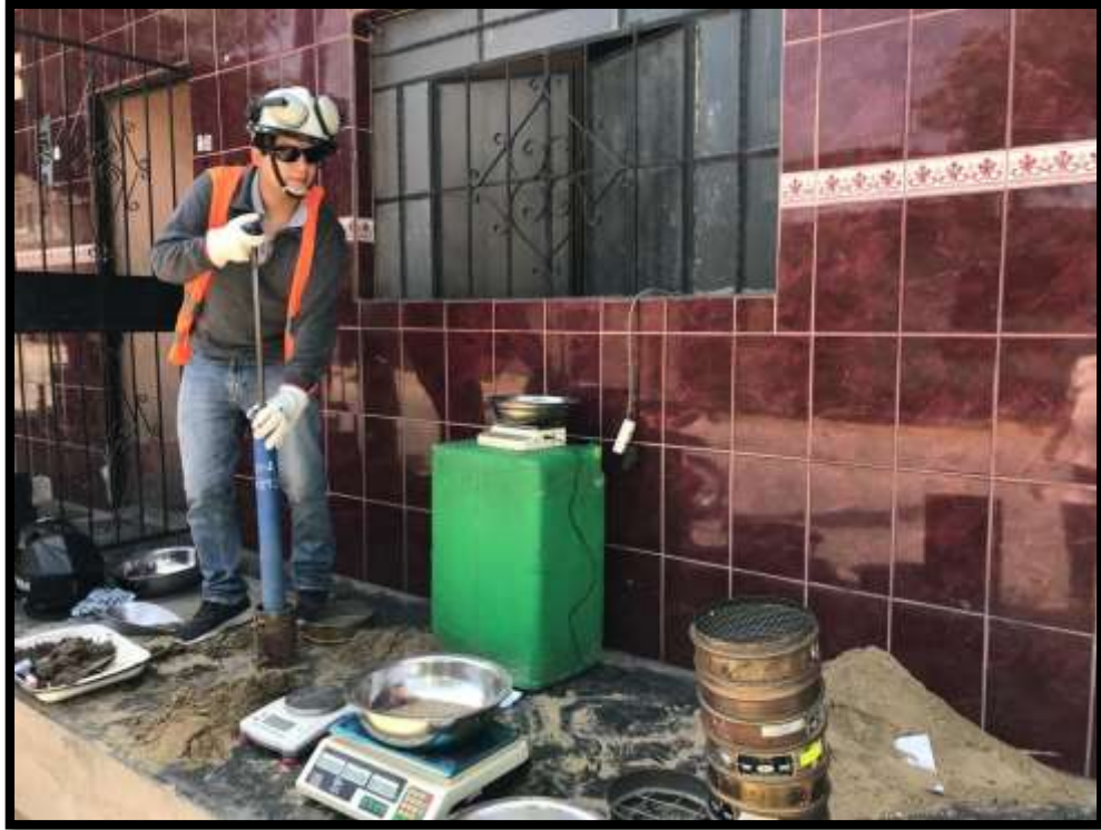
Figura N° 33: Ensayo de PROCTOR
