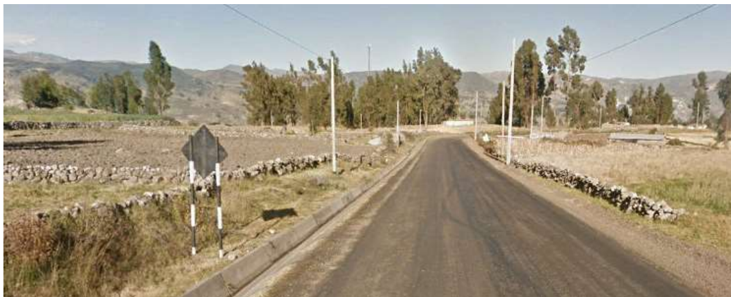
Carretera Interoceánica – ingreso hacia el terreno
