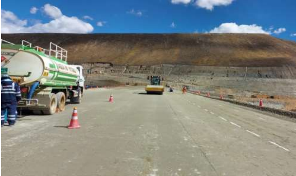
Compactación de las capas con rodillo vibratorio en el Dique
