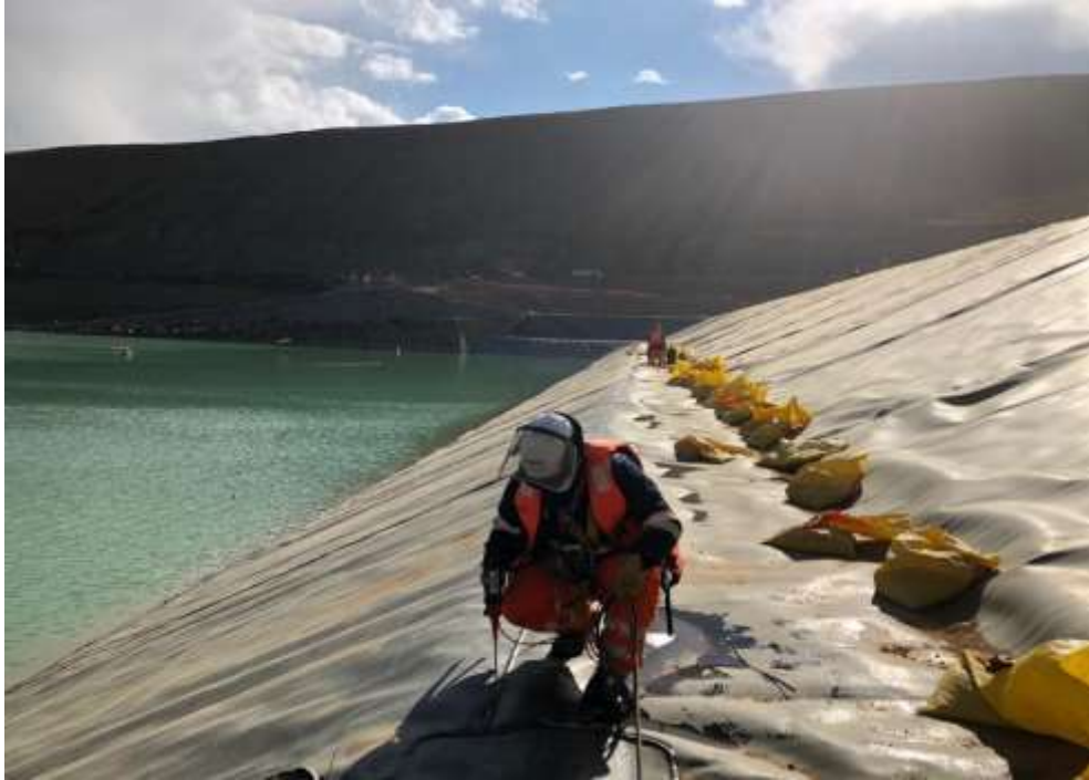
Colocación de Geomembrana
