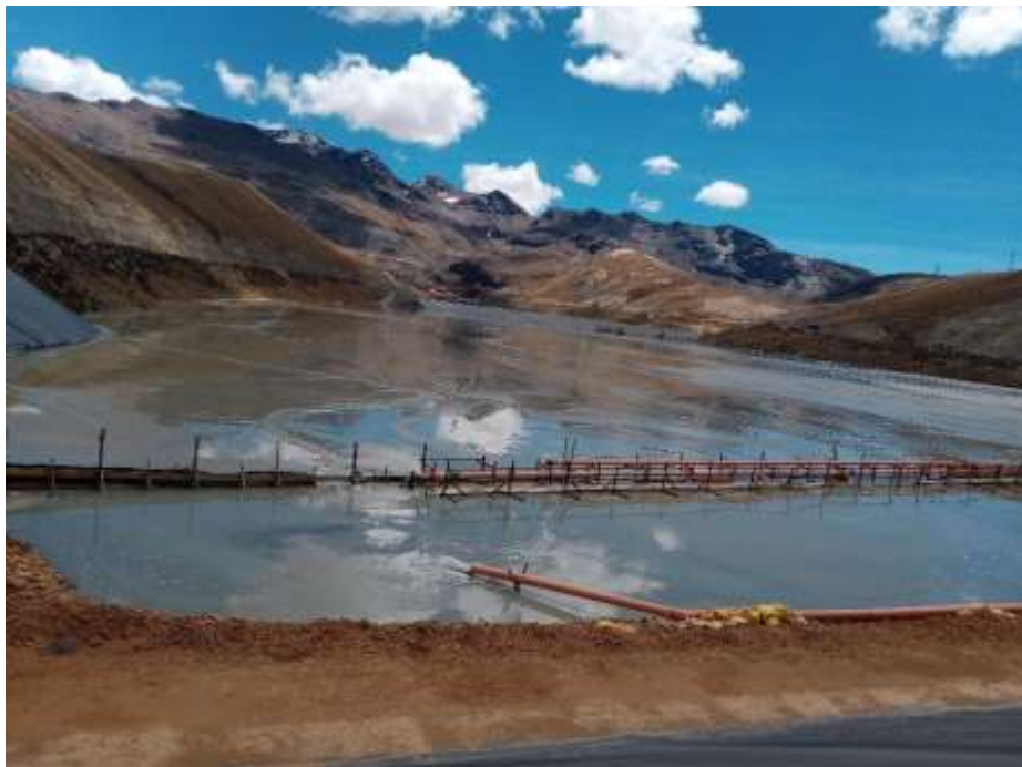
Figura 4: Vista del dique el cual está llegando a su máxima capacidad
