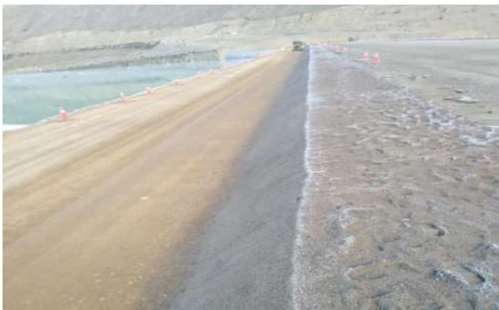
Colocación del material filtro dren
