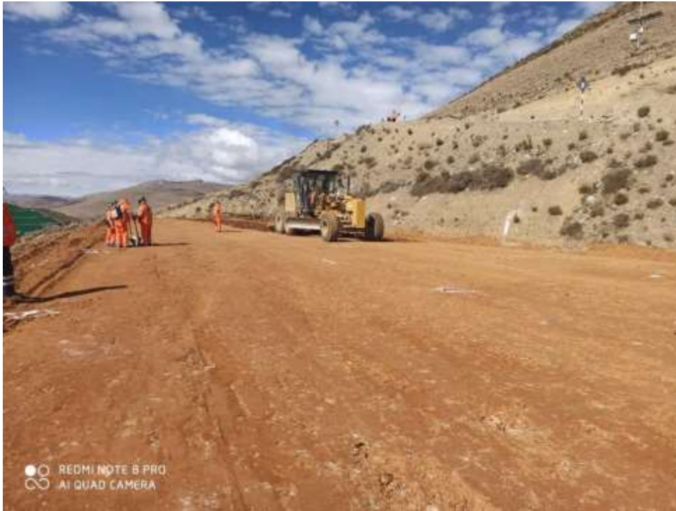
Colocación del material por capas en el dique
