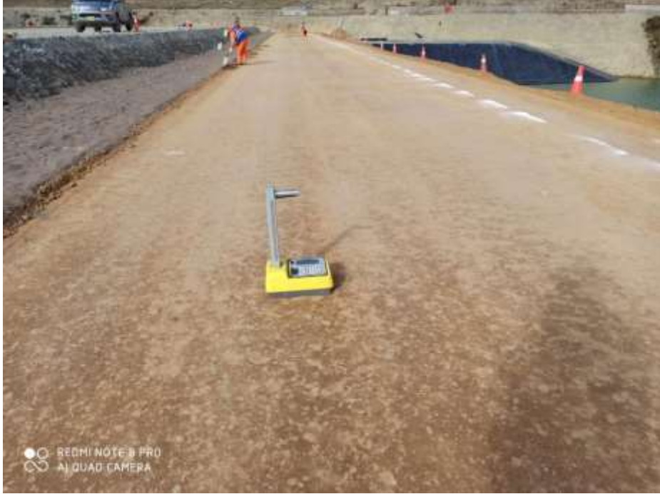
Ensayo de compactación con densímetro nuclear
