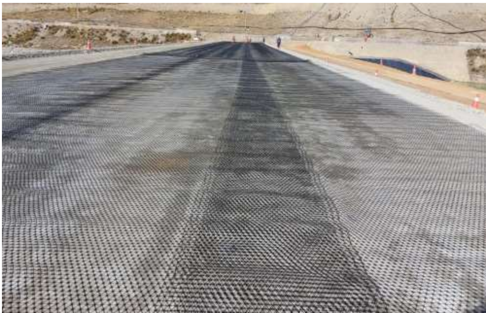
Colocación de Geomalla Triaxial
