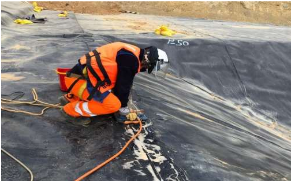
Colocación de Geomembrana
