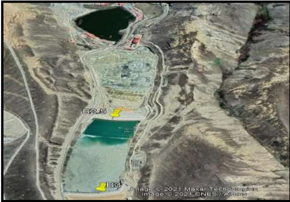
Figura 3: Vista del proyecto
