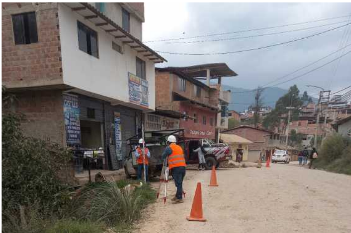
Fotografía 16. "Nivelación de terreno"
