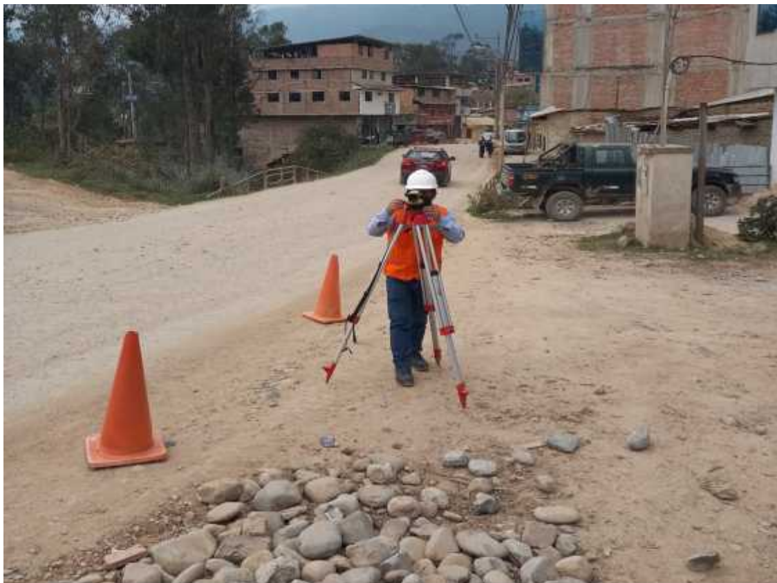
Fotografía 18. "Nivelación de terreno"
