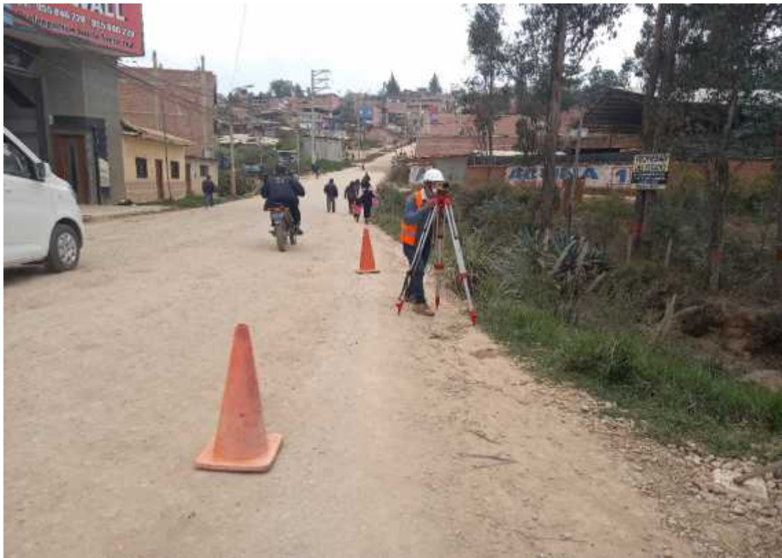
Fotografía 15. "Nivelación de terreno en la zona de estudio"
