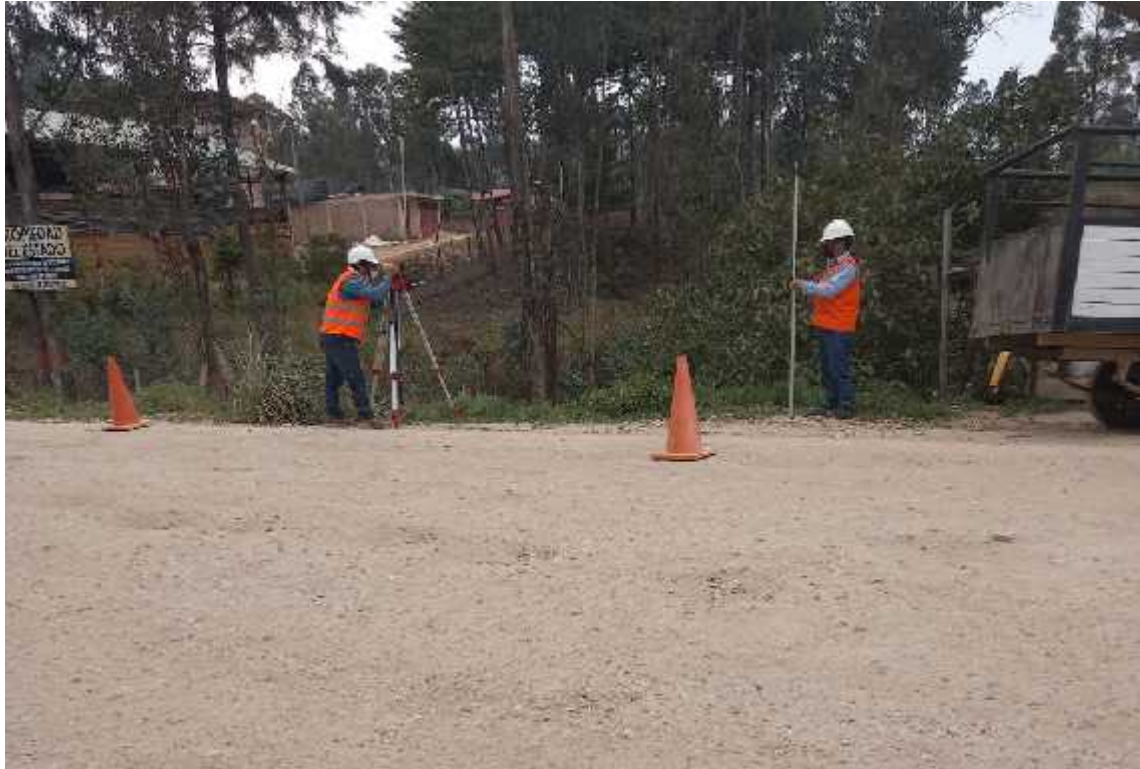
Fotografía 17. "Nivelación de terreno"
