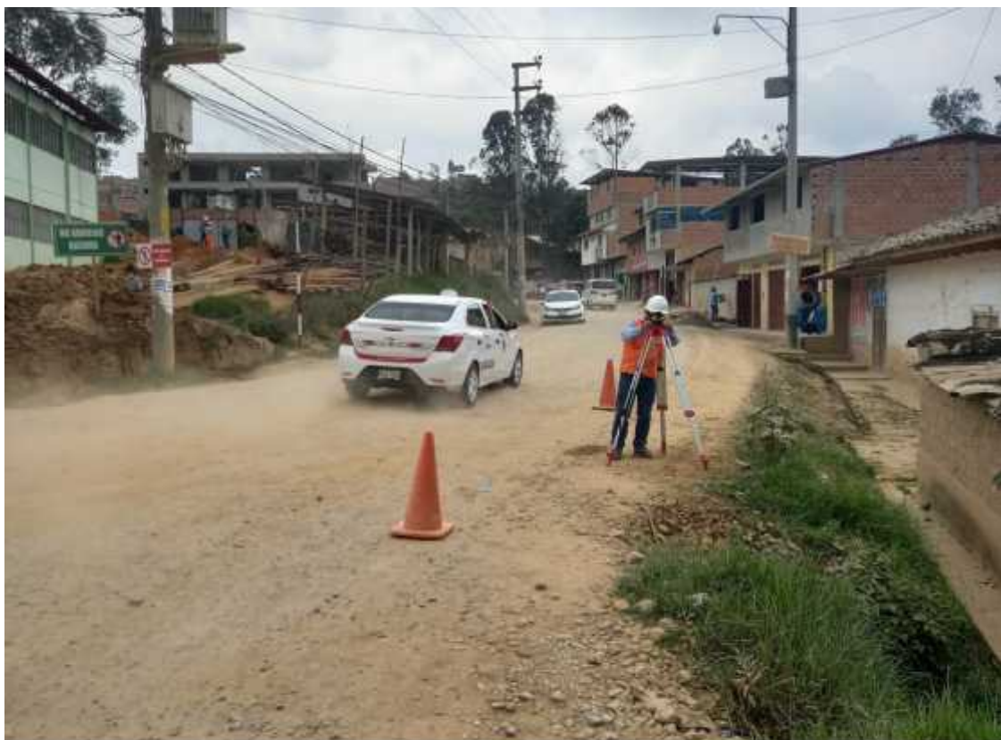
Fotografía 14. "Realizando nivelación de terreno con nivel de ingeniero en el punto de inicio de la zona de estudio"
