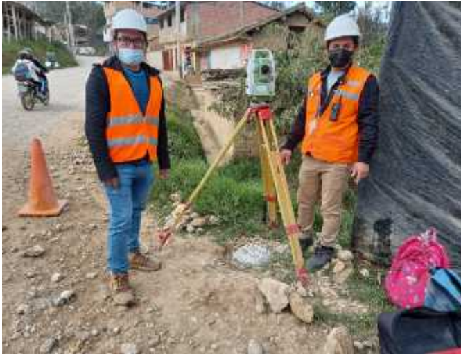
Figura 5. "Reconocimiento del terreno y levantamiento topográfico"
