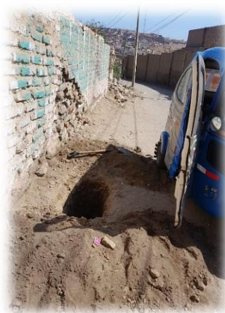
Fotografía 4 Excavación de calicatas
