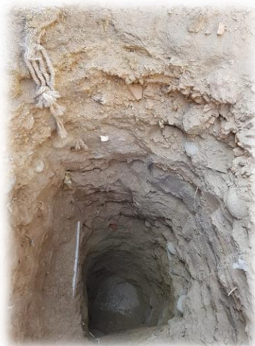
Fotografía 5 Excavación de calicatas
