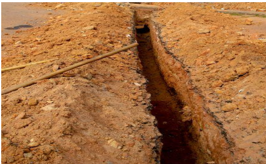
ANEXO 37: Zanjas sin perímetro de seguridad
