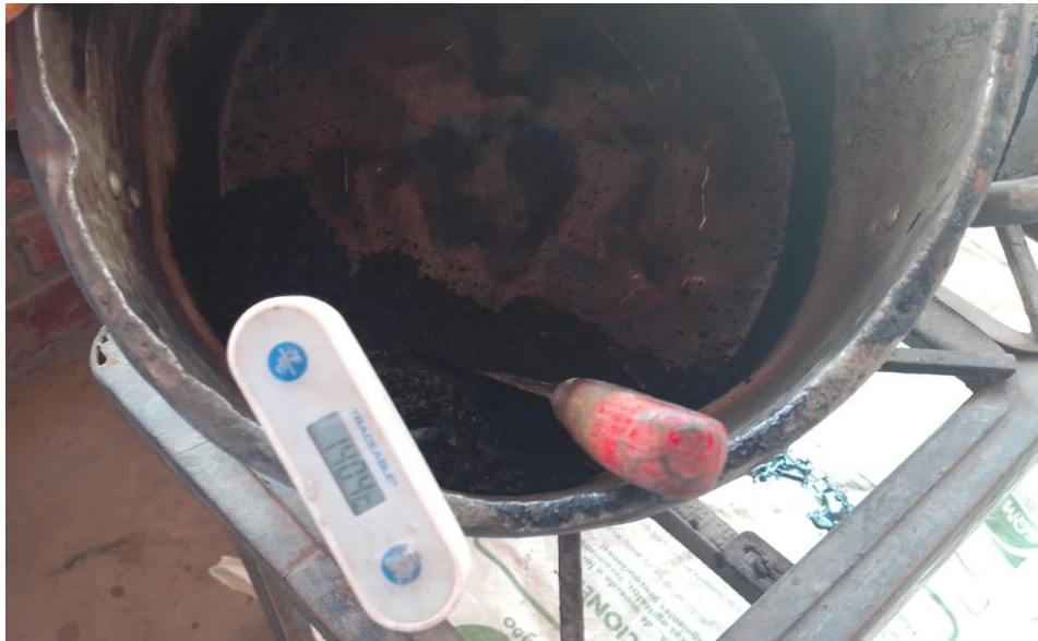
Figura 49: Medida de temperatura de mezcla asfáltica en caliente.
