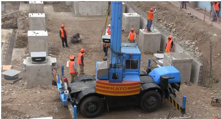
Figura 6. Colocación de aisladores en una edificación de la FIC-UNI
