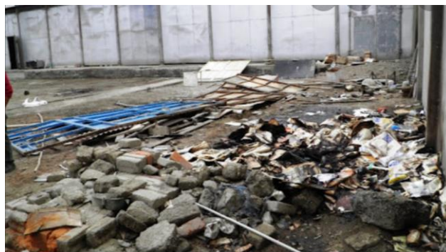
Figura 2: Interior de la ex Estación Ferrocarril.
