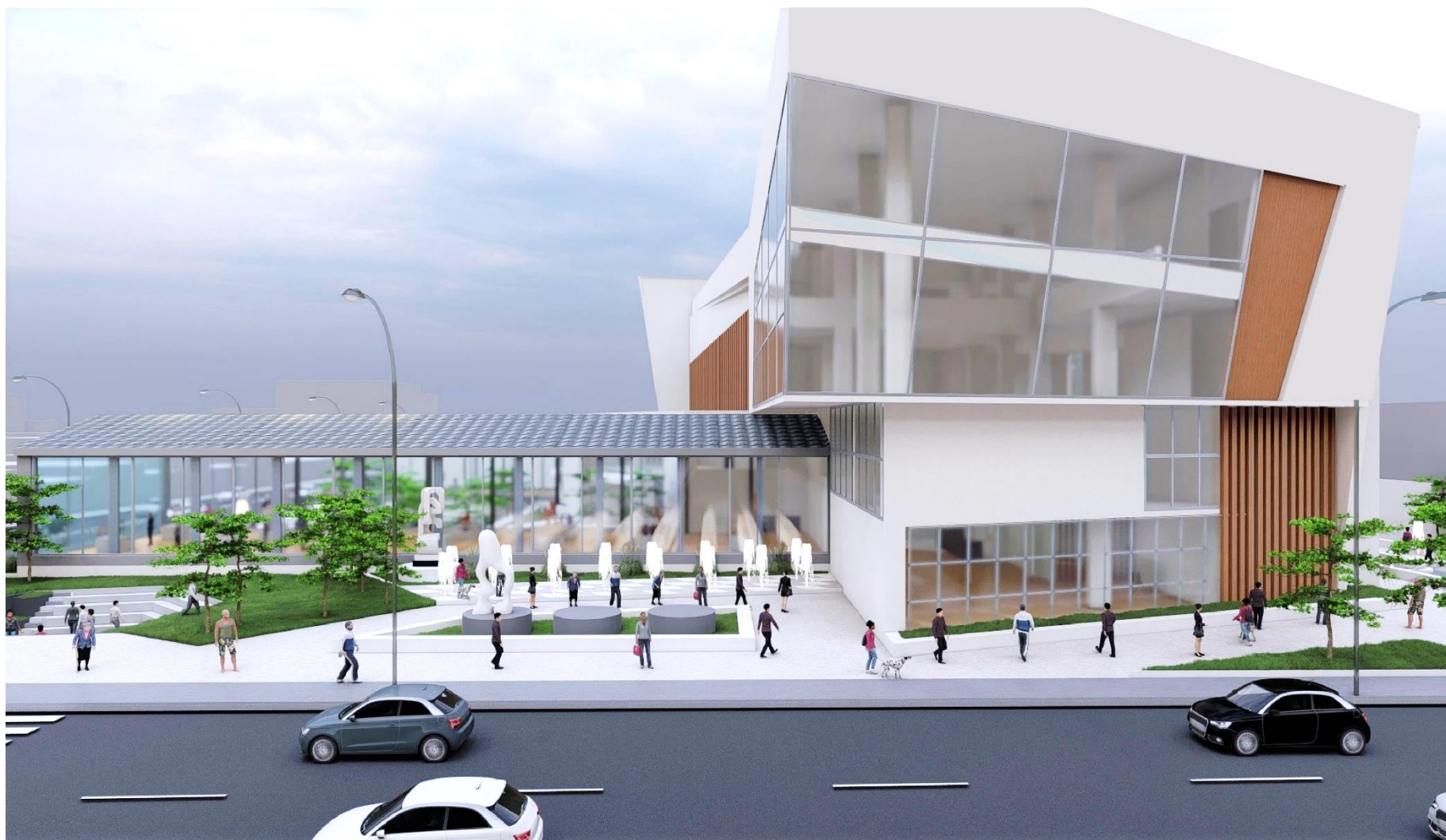
Figura 126: Vista de la Avenida José Gálvez
