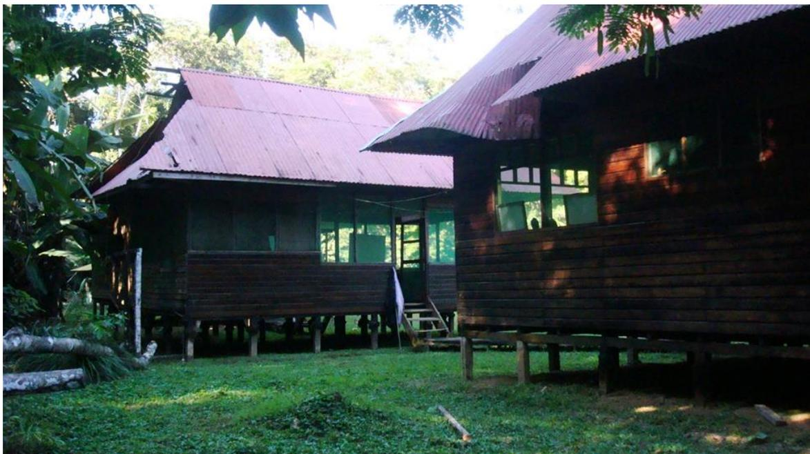
*Nota:* Se puede ver que algunas reparaciones no han sido hechas por completo degradando más la edificación al tener reparaciones encima de la estructura debilitada por la corrosión producto de la humedad esto ha producido el colapso de la estructura antigua haciendo que la calamina se deforme. Las deficiencias en el comedor son notorias por el poco mantenimiento a través del tiempo que ha producido el desgaste ya visto en las fotos anteriores.
