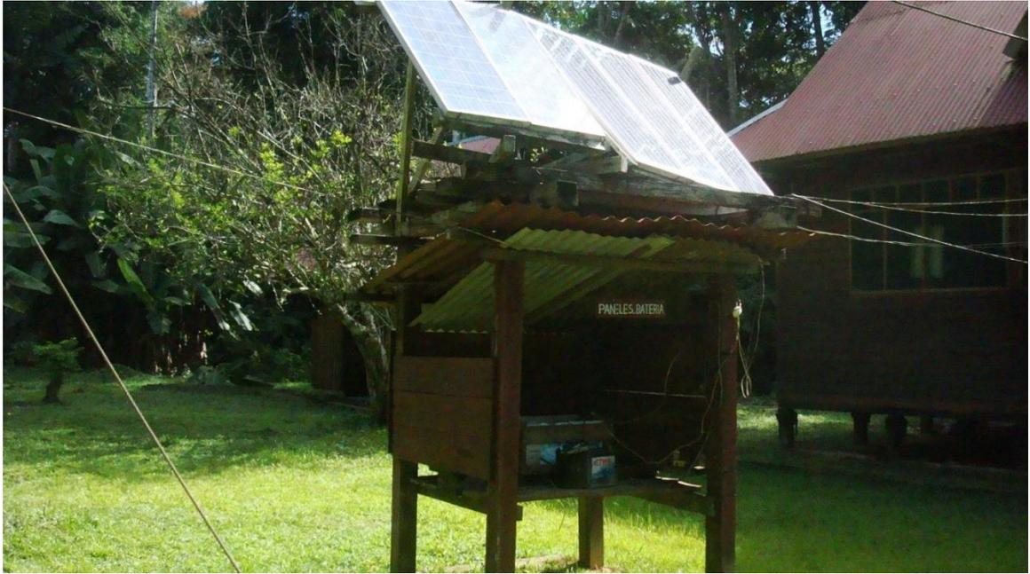
NOTA: En el patio se encuentran la antena de radio comunicaciones que es alimentada por un conjunto de paneles solares los cuales brindan la justa energía para mantener la radio en funcionamiento (el puesto es alimentado a través de otra fuente de energía).
