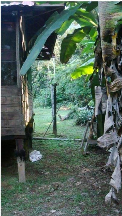
*Nota:* foto de la parte posterior de la cocina desde la despensa se nota el desgaste en el machimbrado de la pared. El techo agujereado se puede visualizar, la parte posterior del comedor se nota en total descuido de no haber recibido un mantenimiento en décadas.
