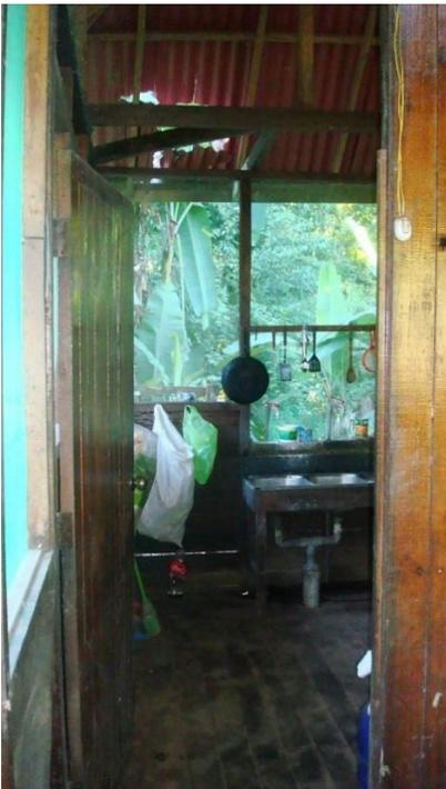
*Nota:* Ingreso a la cocina se puede apreciar el interruptor y las instalaciones han sido adicionadas sin utilizar ningún tipo de reglamentación o conocimiento técnico calificado. Se ve que el techo tiene orificios producto de la corrosión por humedad característico del verano en la selva baja, el piso está en malas condiciones
