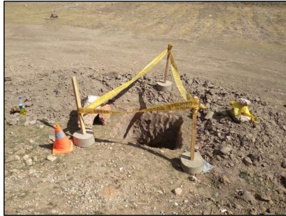
Figura 5. Excavación de la calicata
