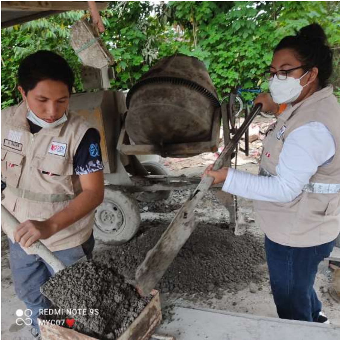
ELABORACION DE LOS BLOQUES DE CONCRETO
