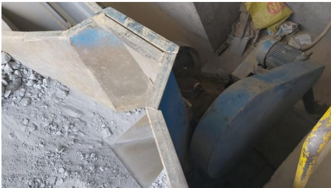
Embudo por donde ingresa el material al molino.
