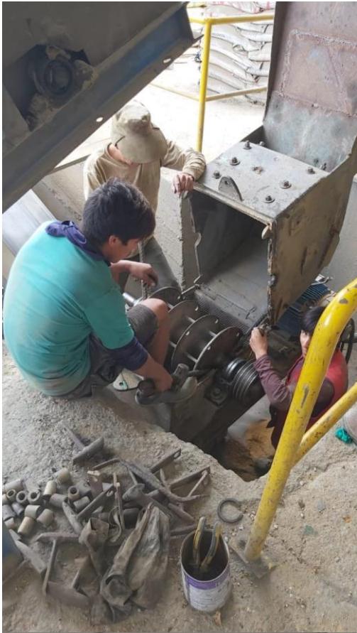
Chancadora. Parte del molino que tritura el material. Foto mientras se realiza mantenimiento correctivo.
