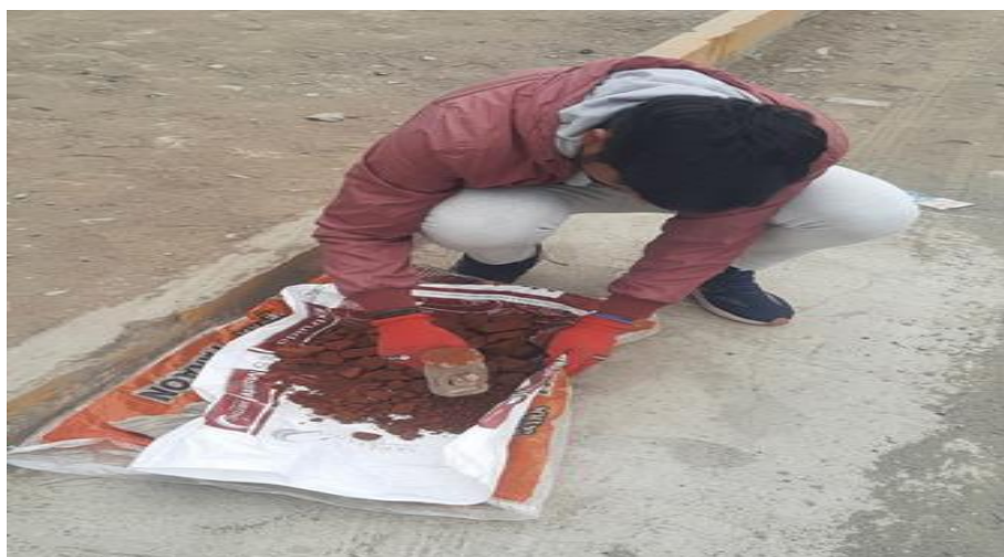
Picado del ladrillo rococho para remplazar en la arena gruesa
