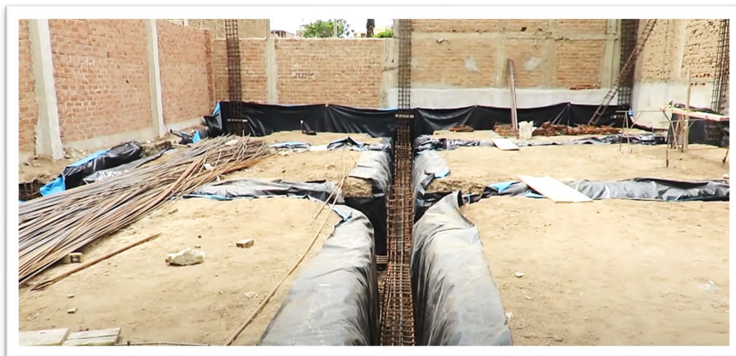
Figura N° 20 Cimentación de la edificación
