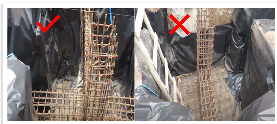
Figura N° 23 Verificación previa al vaciado de concreto
