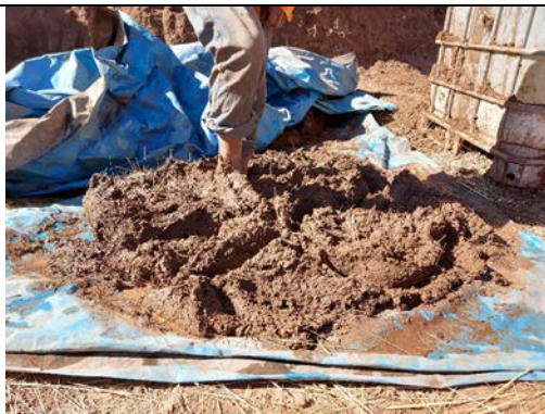
Paso N° 10: Mezcla de barro lista para el moldeo (adobe patrón)
