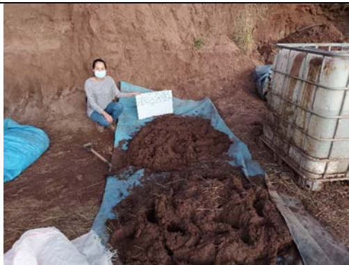
Paso N° 09: Dormido de la mezcla de barro
