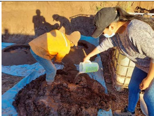
Paso N° 08: Preparación del barro para la elaboración de adobes
