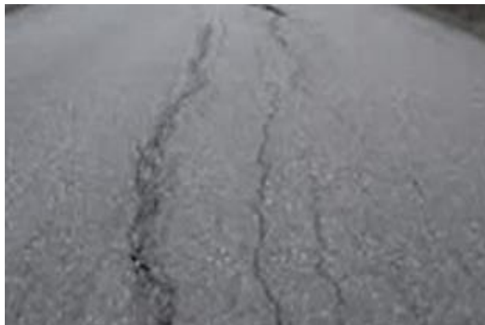
Figura 10. Grietas longitudinales / transversal
