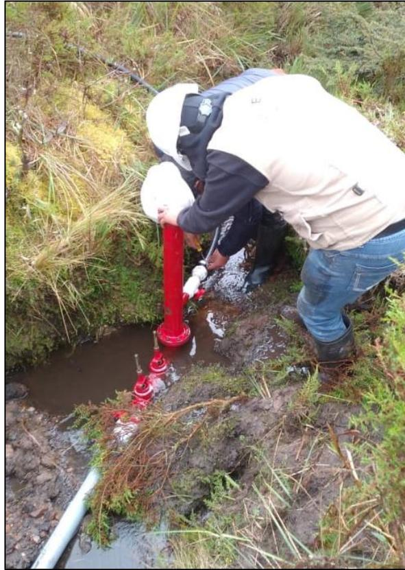
Fotografía 5. Ubicación de la bomba de ariete hidráulico a 4 metros de altura de alimentación.
