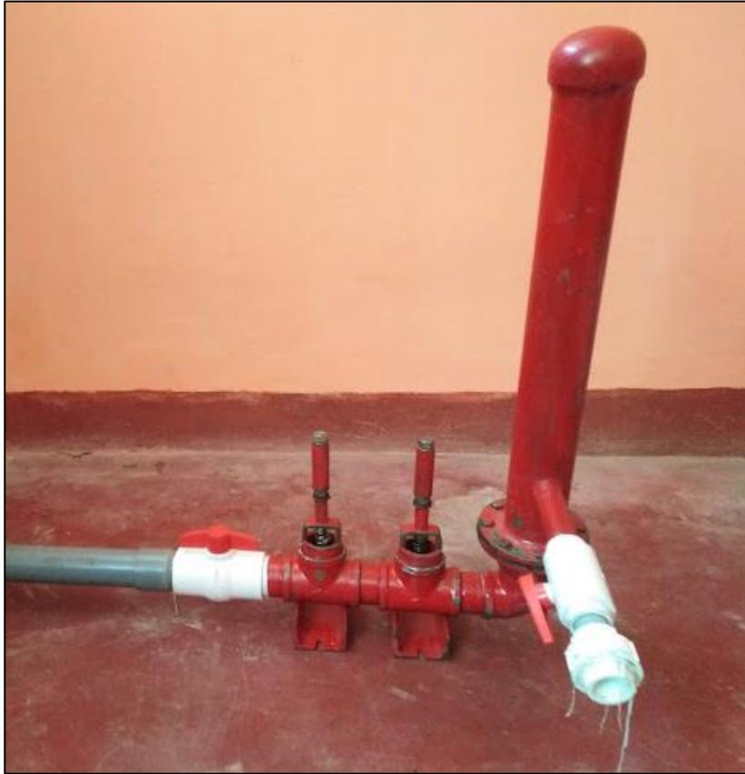
*Figura 4.* Prototipo de bomba de ariete de entrada de 2 pulgadas y 1 pulgada de salida (INDES-CES UNTRM).
