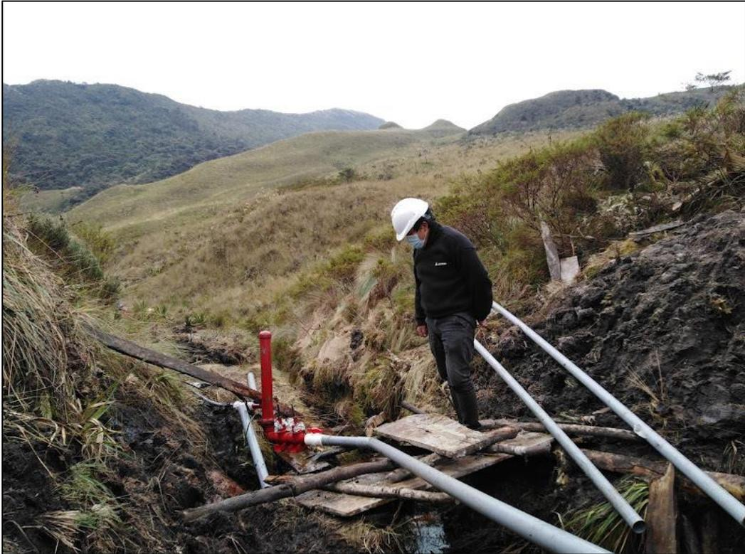
Fotografía 3. Ubicación de la bomba de ariete hidráulico a 1 metro de altura de alimentación.
