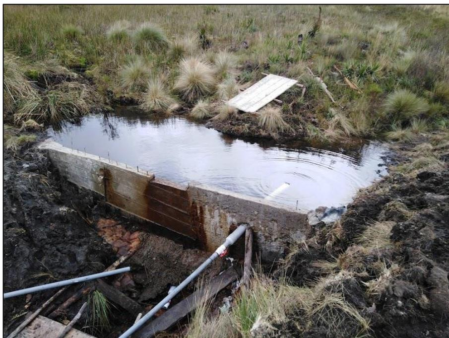
Fotografía 2. Captación de agua para alimentación a la bomba de ariete hidráulico.
