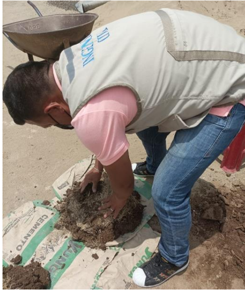
Figura 1. Elaboración de mezclas con bagazo de caña de azúcar para conformado de adobes
