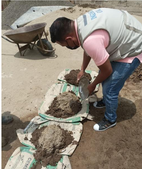
Figura 6. Preparación de mezcla con bagazo de caña de azúcar.
