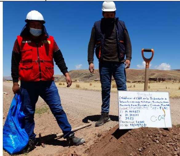
In - situ progresiva 1+500.
