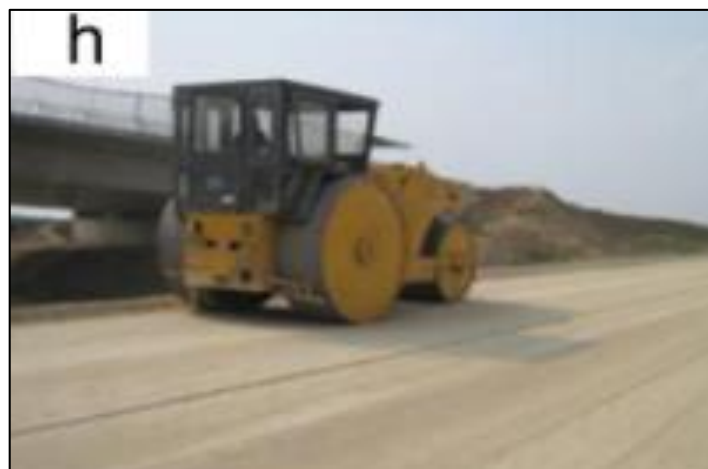
Figura 9. Estabilización de suelos Fuente. Baque-Solis (2020, p. 208).
