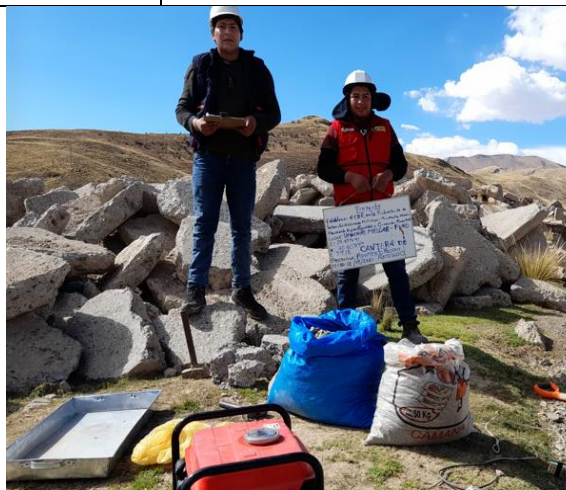
Pavimento rígido reciclado y graduado.
