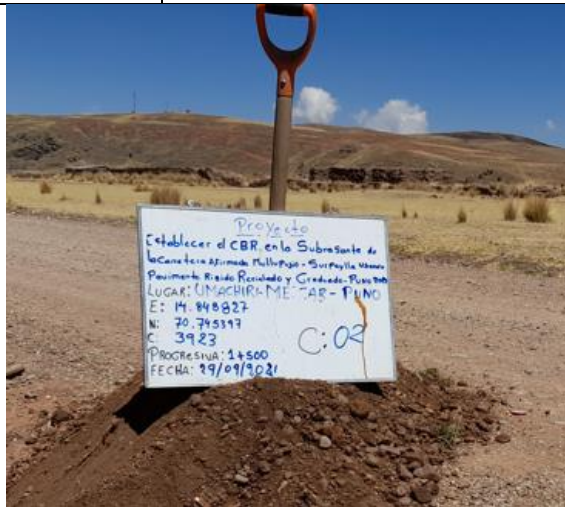
In - situ progresiva 1+500.
