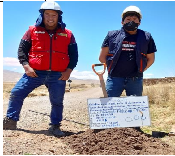
In - situ progresiva 6+500.
