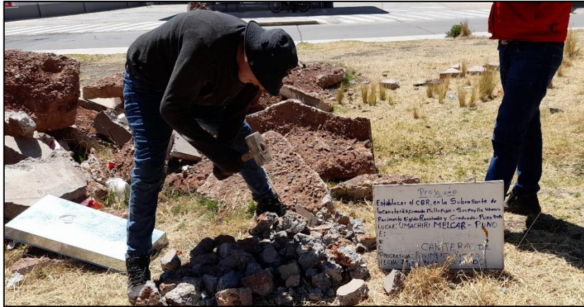
Figura 22. Triturado del pavimento rígido reciclado
