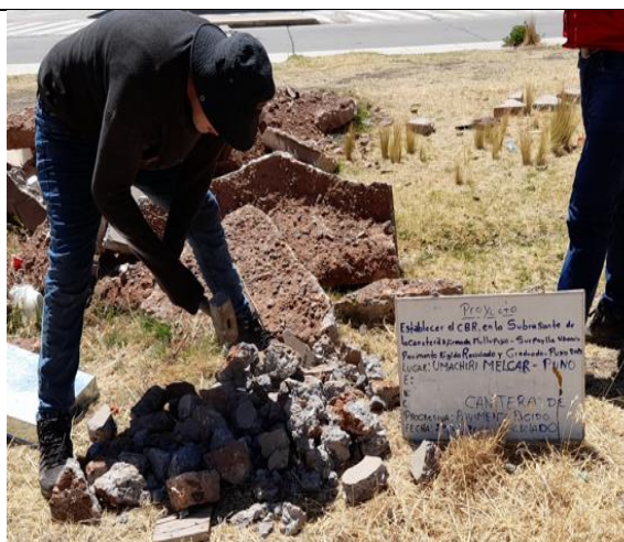
Pavimento rígido reciclado y graduado
