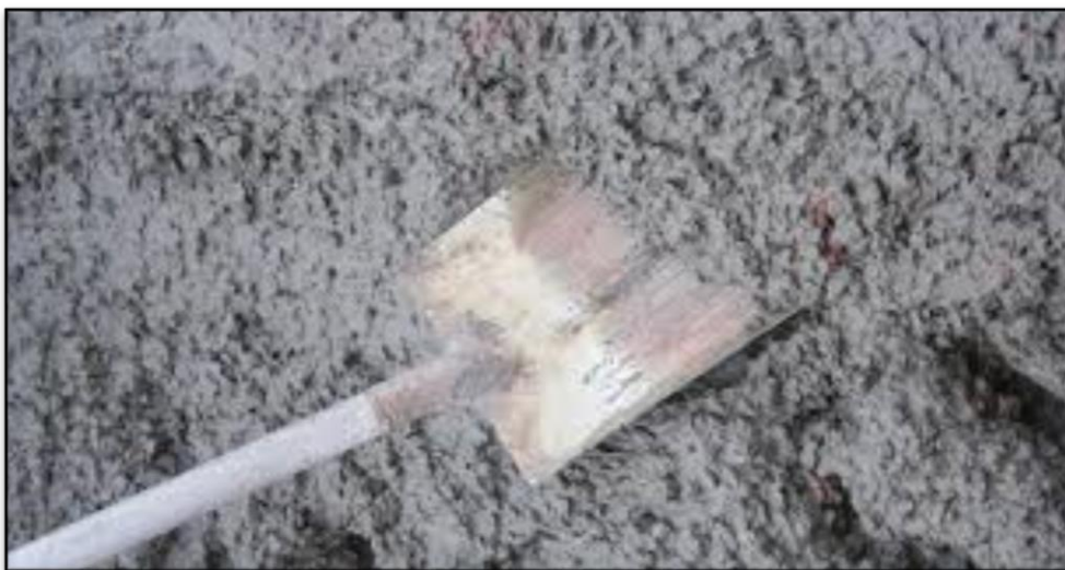
Figura 8. Consistencia de la mezcla de mortero
