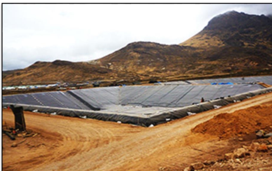
Figura 3. Construcción de poza de relave
