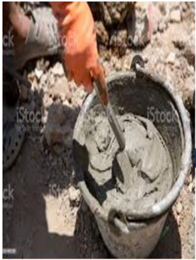
CONSISTENCIA DE LA MEZCLA DE MORTERO
