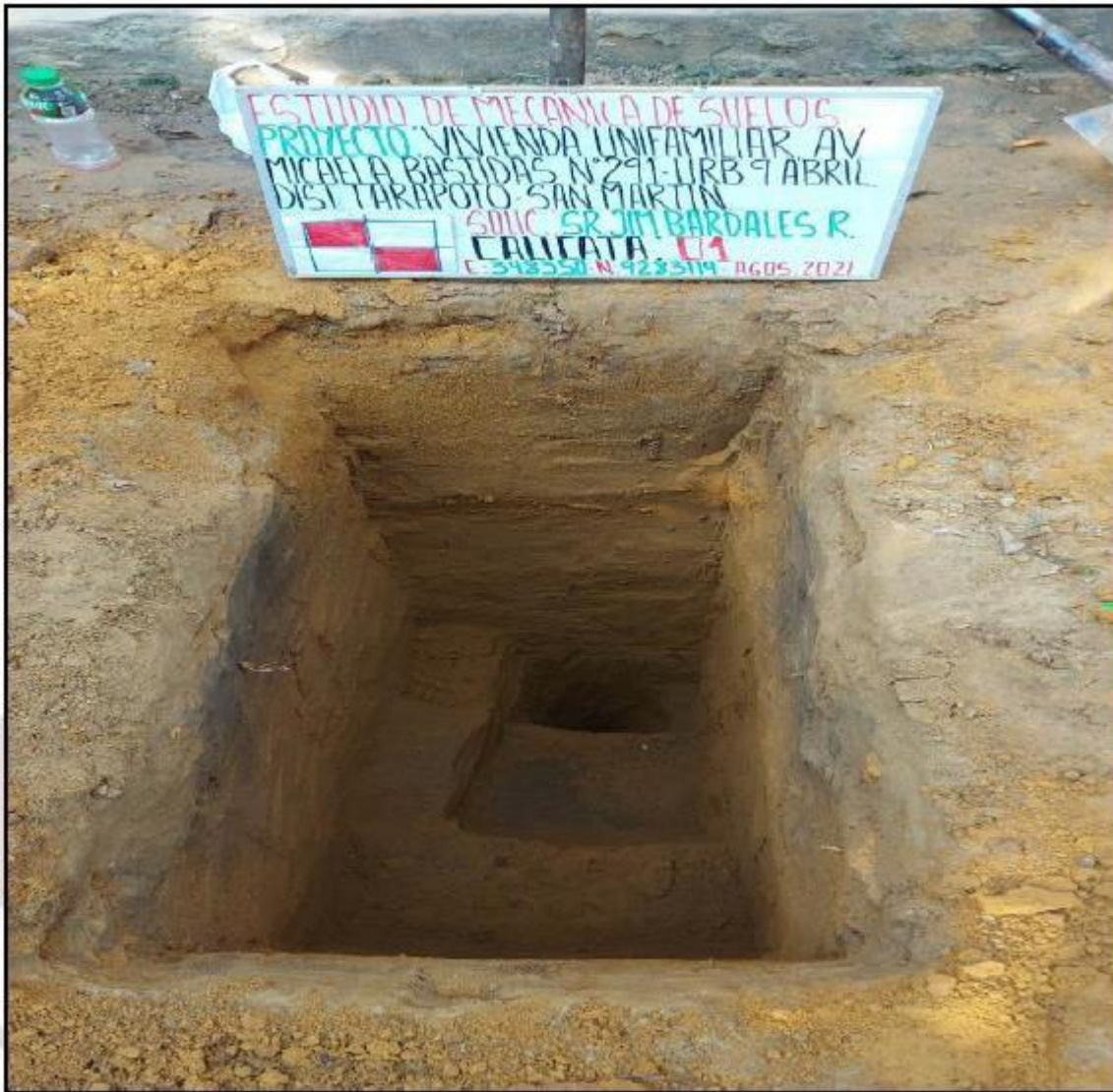
Figura 8. Se observa calicata excavada
