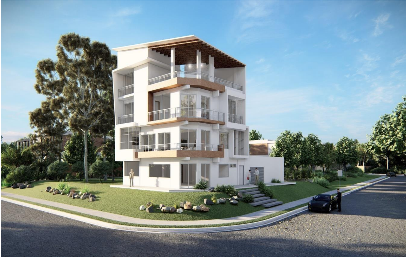
Figura 96. Vista frontal del edificio multifamiliar
