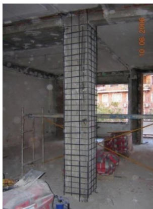
Figura 1. Columna durante el proceso de recrecido
