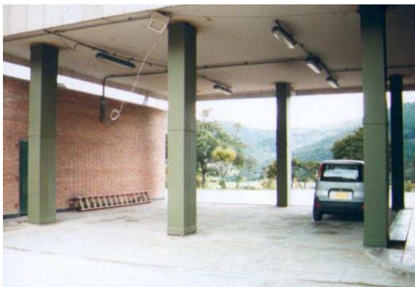
Figura 2. Encamisado de acero
