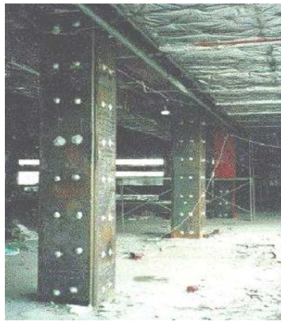
Figura 3 Encamisado con planchas de acero
