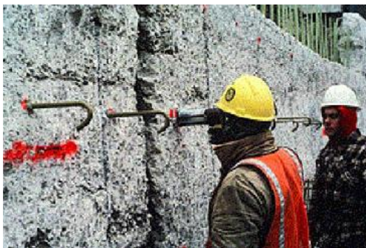
Figura 5 Ubicación de los anclajes en el muro de corte
