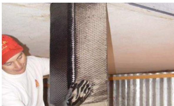
Figura 4 Columna encamisada por fibra de carbono
