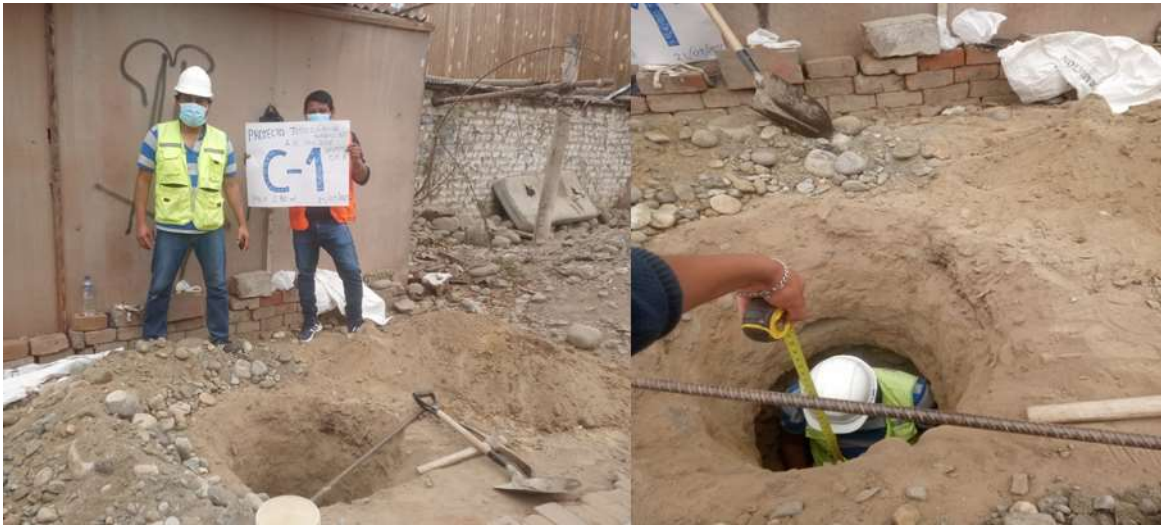
Figura 1: Fotos de excavación de calicata en el A.H. San José.
