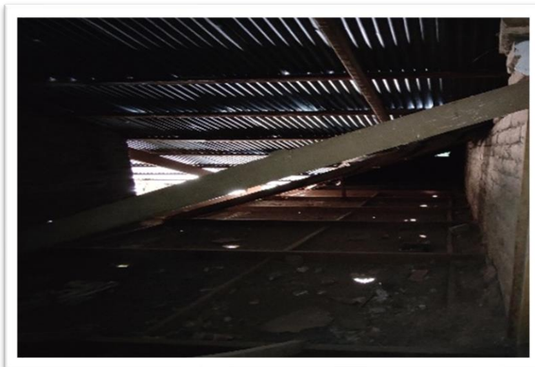
Figura 30. Viga de madera deteriorada por la filtración de agua a efecto de goteras.
