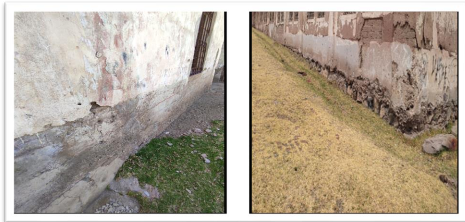
Figura 14. Sobrecimiento del primer nivel de la Institución “José Antonio Encinas” Fuente: Producción propia de los tesistas.
