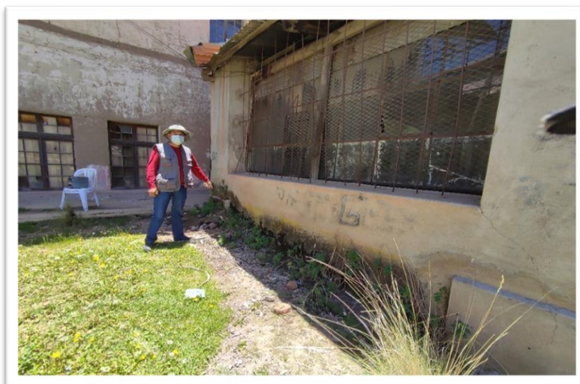
Figura 32. Vegetación en muros.
