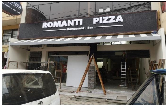
Figura N° 26: Proceso de instalación
