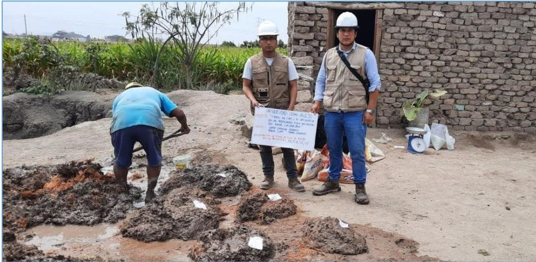
**Figura N° 12:** Preparación de la mezcla a los diferentes % para dejar en reposo o dormido por 24 horas
