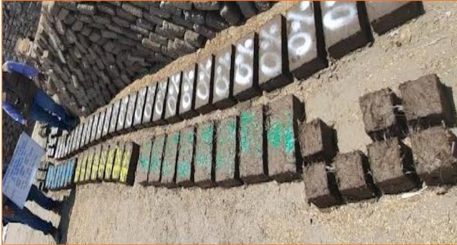
**Figura N° 14:** Tendido y secado del adobe
