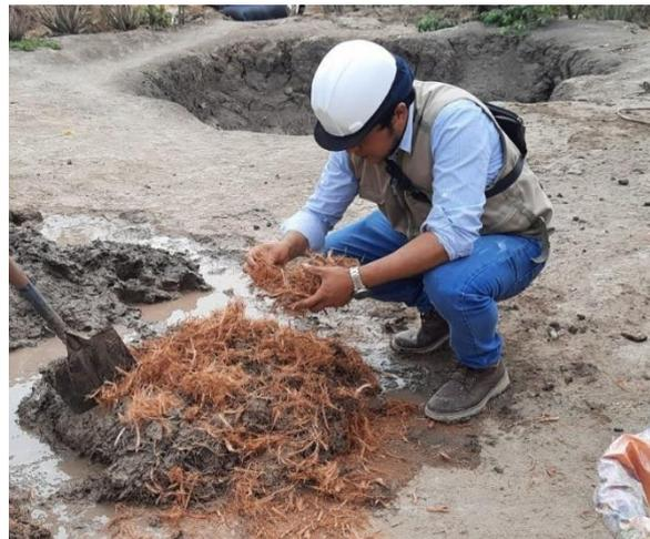
**ANEXO 21:** Mezcla de barro con la fibra de coco para el dormido de 24 horas
