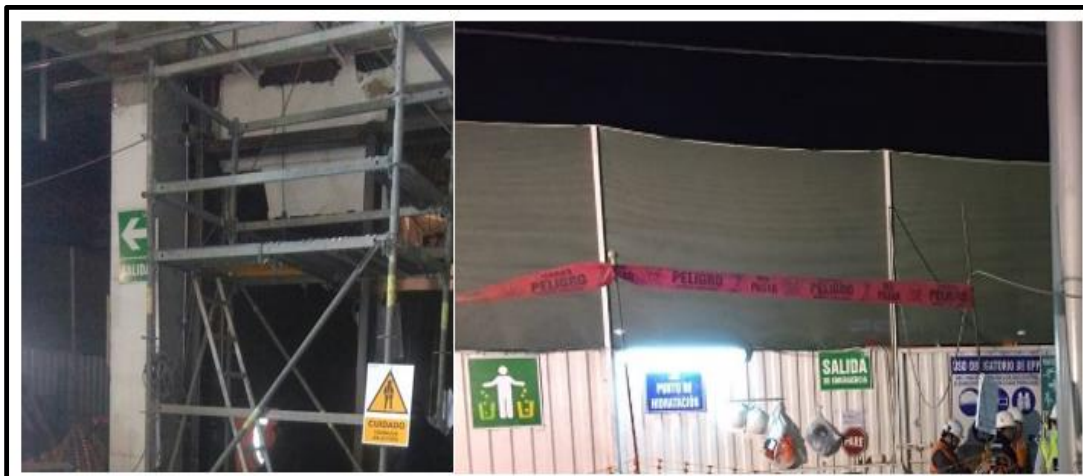
Figura 10. Señalización en la obra.
