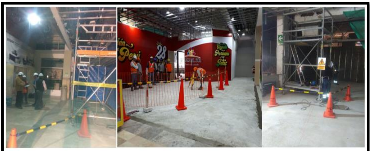
Figura 8. Señalización en la obra.
