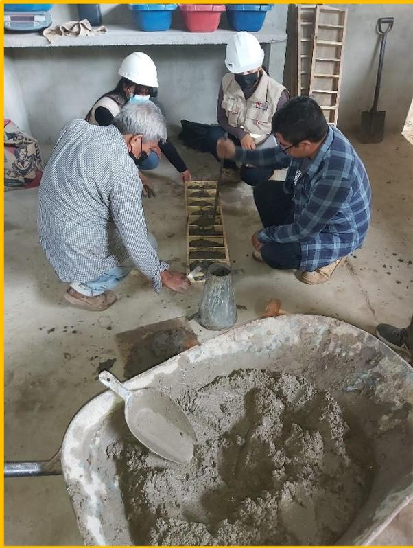
**FOTOGRAFÍA N° 3:** Vaciado de diseño de mezcla  $f'c=380 \text{ kg/cm}^2$  para adoquines convencionales.
