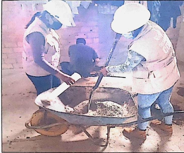
Proceso de adición del agua de diseño para el moldeo del concreto y elaboración de los adoquines de calidad  $f_c = 380 \text{ Kg/cm}^2$
