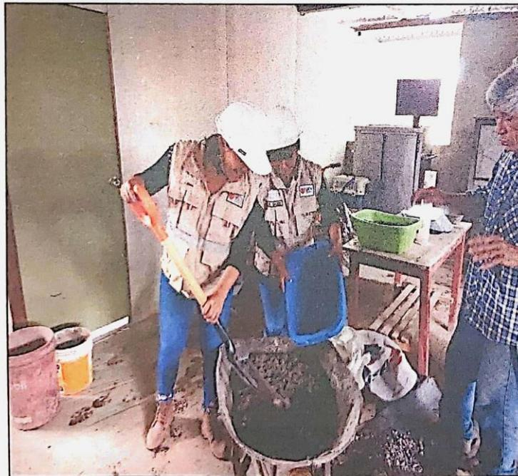
Proceso de batido de la mezcla para el moldeo del concreto y elaboración de los adoquines de calidad  $f_c = 380 \text{ Kg/cm}^2$
