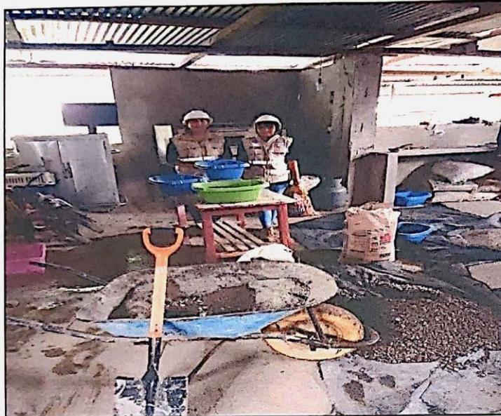
Proceso de pesado de materiales, agregado fino y grueso para el moldeo del concreto y elaboración de los adoquines de calidad  $f_c = 380 \text{ Kg/cm}^2$
