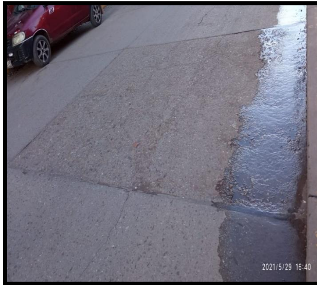
Figura 58: Gravedad 2-Desprendimiento.
