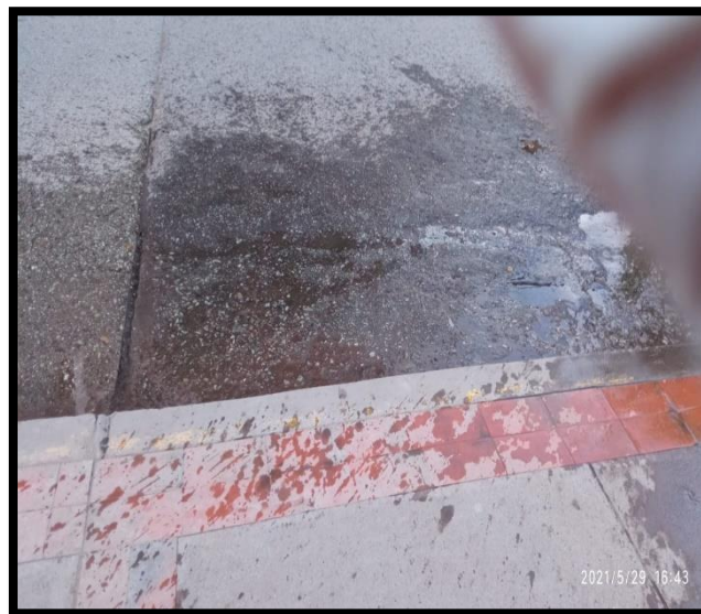
Figura 60: Gravedad 3-Desprendimiento.
