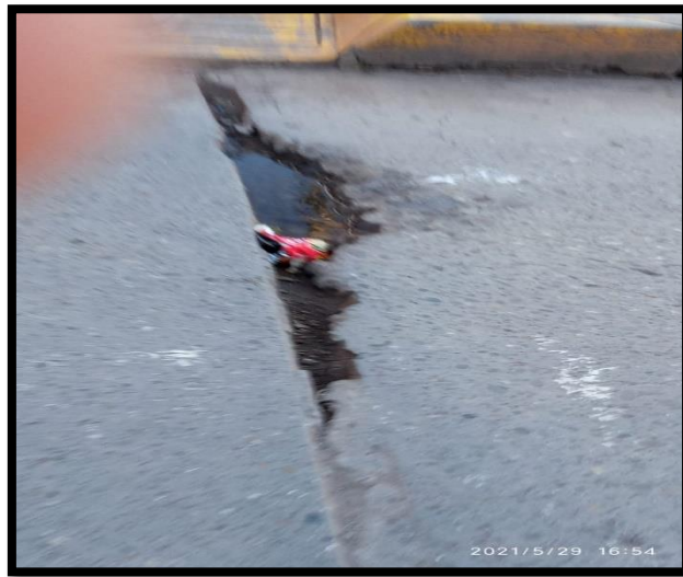
Nota: Gravedad 2-Diámetro entre 0.2 y 0.5 m
