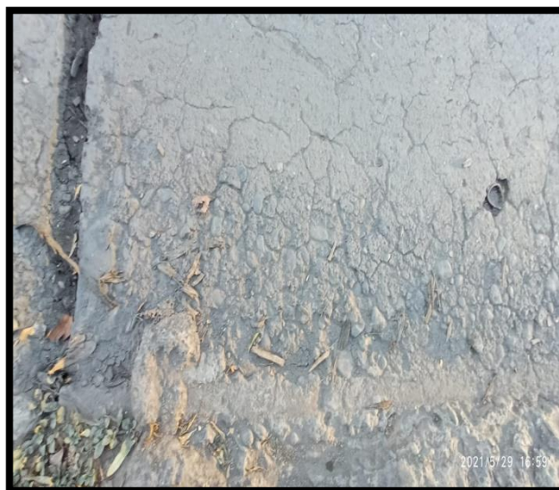
Figura 56: Gravedad 1-Desprendimiento.
