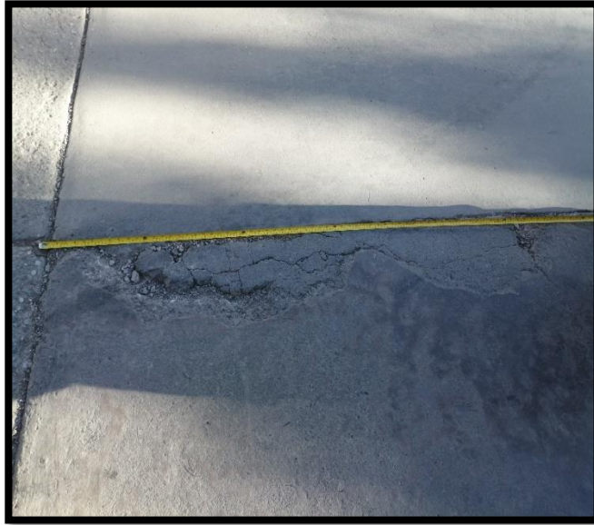
Nota: Gravedad 1- Puntuales (menor al 10% de la superficie)
