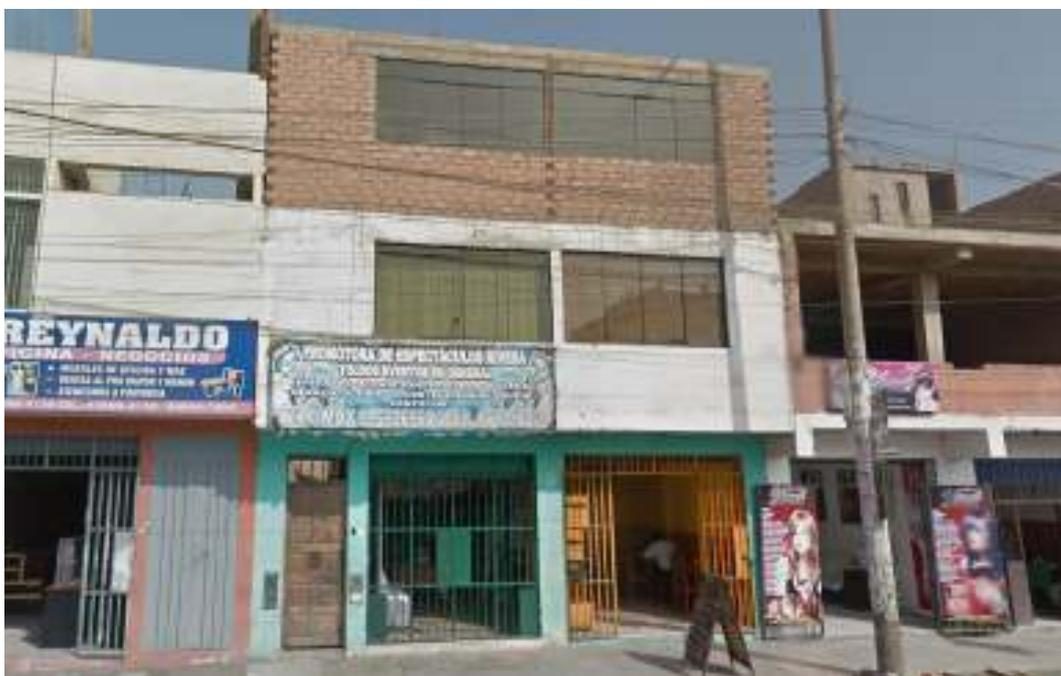
Figura 3. Edificaciones de albañilería confinada con ladrillos pandereta
