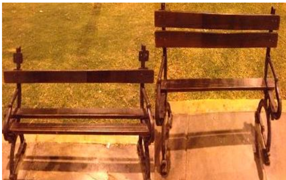
ILUSTRACIÓN 1. BANCAS EN MAL ESTADO EN PARQUE DEL DISTRITO DE BELLAVISTA FUENTE: RPP, PORTAL WEB.
