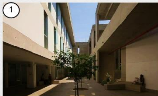
Recorrido espacial en el cual es legible el área de aulas y terrazas dentro del conjunto.
