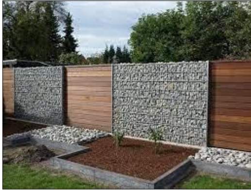
Figura 24 Detalle de Muros gavión
