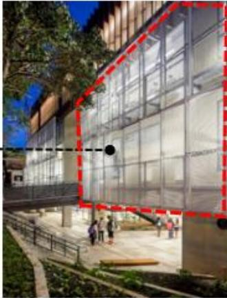
Acabados con paneles de aluminio con perforaciones colocados en la fachada
