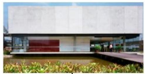
Se utiliza concreto en la parte superior del proyecto y vidrio en la parte inferior en la fachada para mayor iluminación en la parte de adentro
