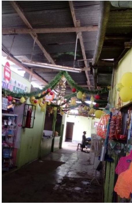
Fuente: Foto sacada de google maps
