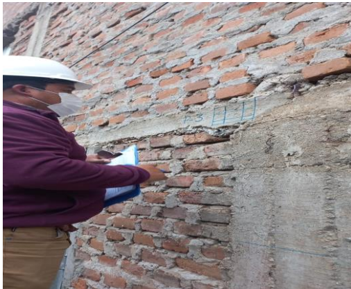
Ensayo de esclerometría P-3 (Viga)
