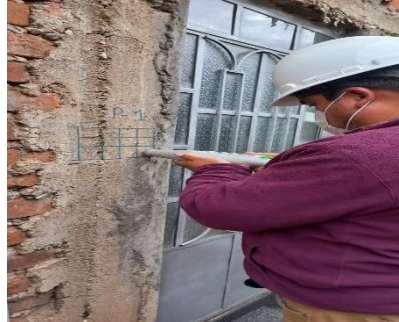
Ensayo de esclerometría P-1 (Columna)
