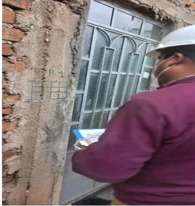
Ensayo de esclerometría P-1 (Columna)
