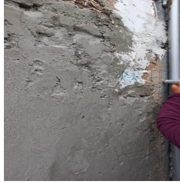
Ensayo de esclerometría P-2 (Columna)
