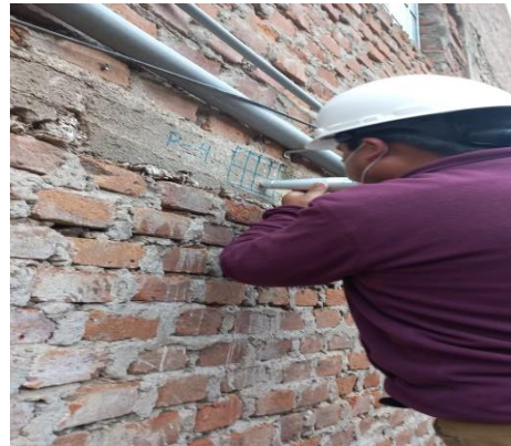
Ensayo de esclerometría P-4 (Viga)
