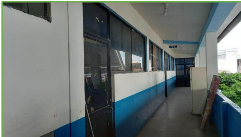
Figura N°11: Vista de elementos estructurales, en el tercer nivel.
