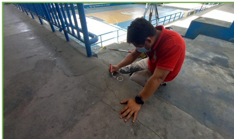
Figura N°03: Se puede observar, el marcado del Beich Mark
