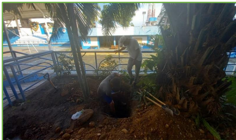
Figura N°13: Vista de excavación de suelo para extracción de muestra.
