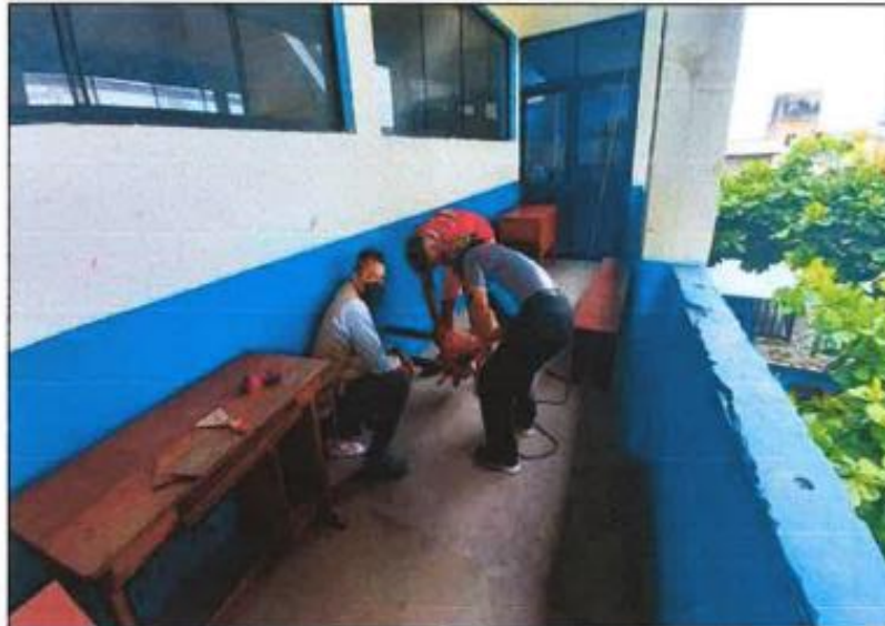
SE OBSERVA EXTRACCION DE TESTIGOS DIAMANTADOS EN OBRA
