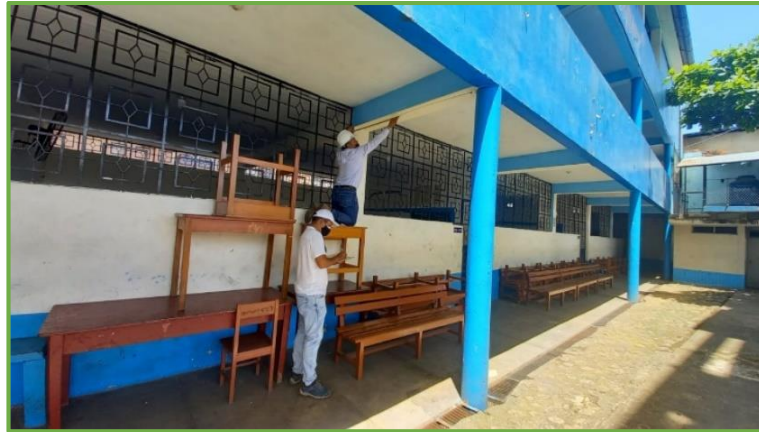
Figura N°08: Vista de elementos estructurales en el primer nivel
