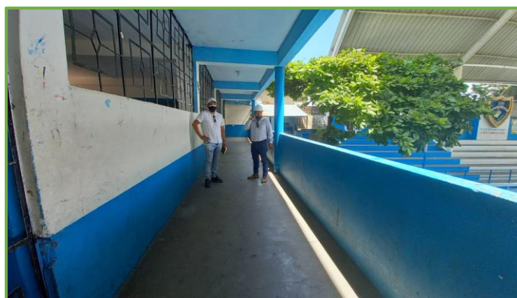
Figura N°31: Vista de los Elementos Estructurales.
