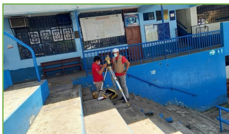
Figura N°04: Vista de estación total N°01
