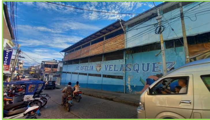
Figura N°32: Vista de inspección de los Muros de Albañilería
