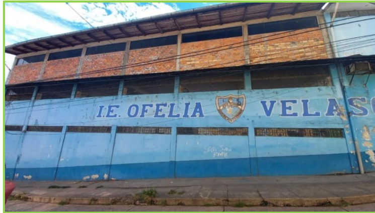
Figura N°44: Elementos No Estructurales
