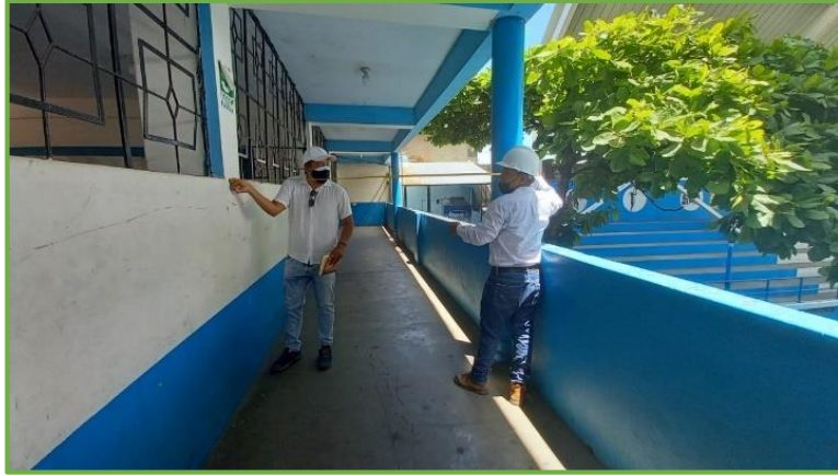
Figura N°10: Vista de elementos estructurales, en el segundo nivel.
