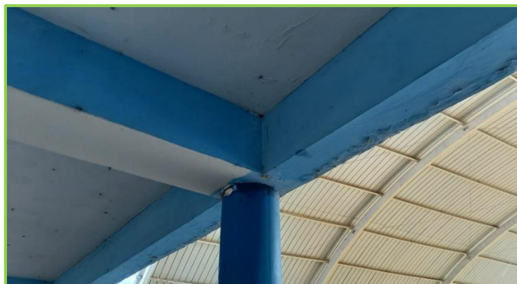
Figura N°40: Vista de Elementos resistentes de Viga-Columna
