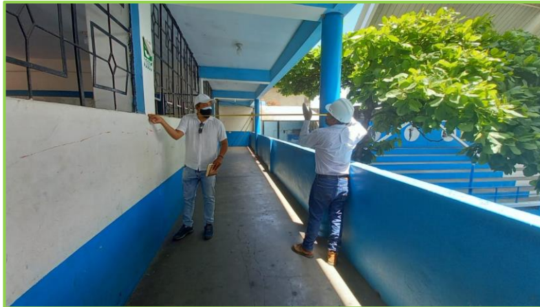
Figura N°36: Vista de los elementos de tipo viga-columna.
